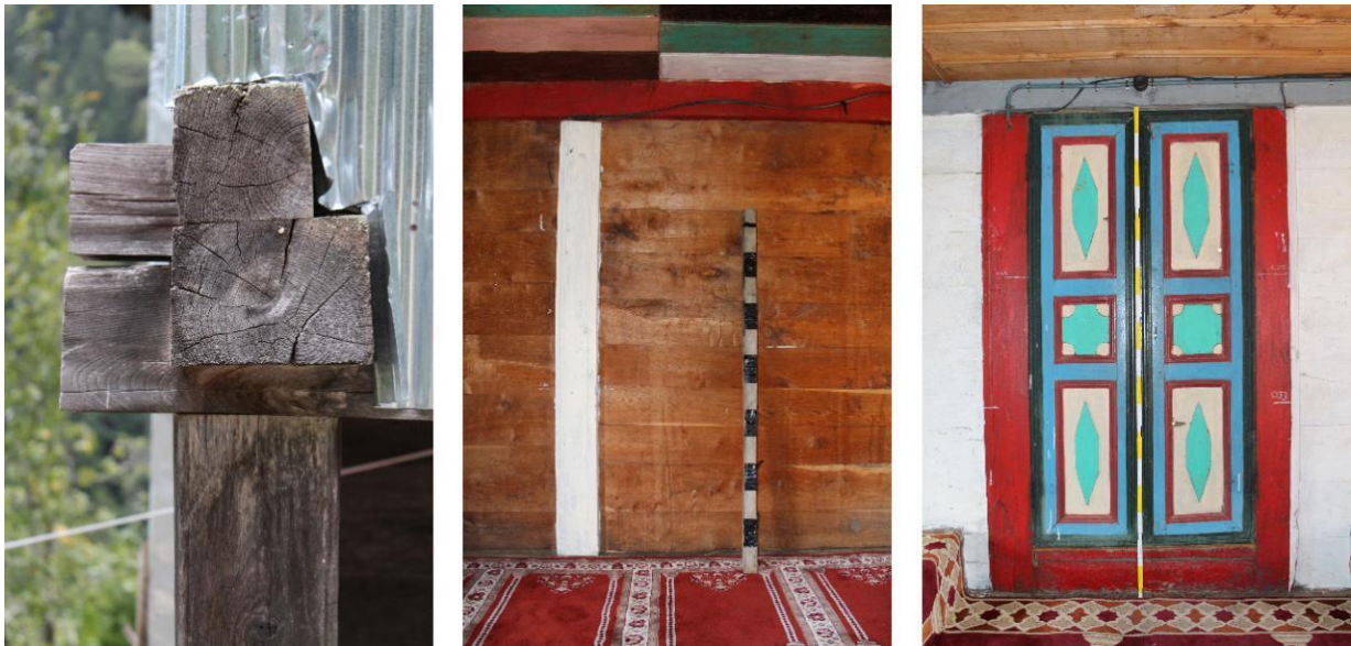
Şekil 3. (Solda) Döşeme kirişleri, (Ortada ve Sağda) Ahşap elemanların birleşim yerlerinde ve kapı boşluklarını sınırlamak amacıyla kullanılan yapı elemanları (Rümeysa Coşkun, 2018)
