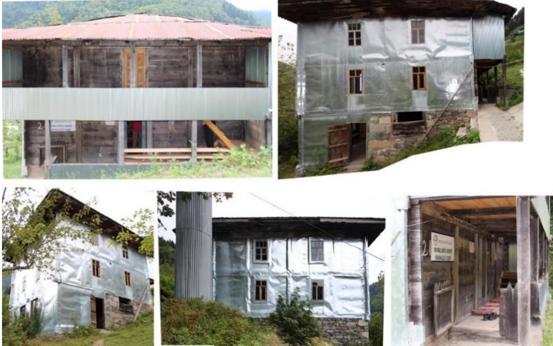
Şekil 23. İrem Camisi kuzey, doğu, güney ve batı cepheleri (Rümeysa Coşkun, 2018)
