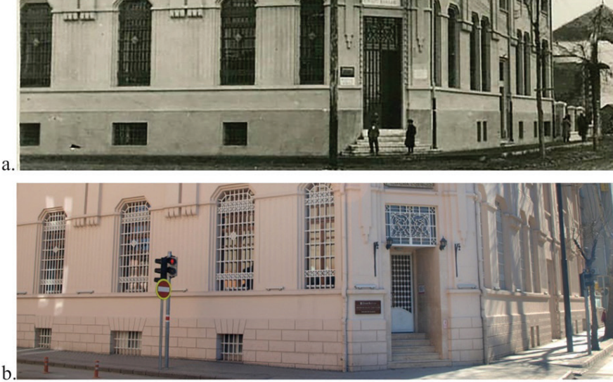
G. 16a. 1930'lu Yıllarda Yapının Kaldırım ile İlişkisi (ETBA) 16b. Günümüzde Yapının Kaldırım ile İlişkisi (Rabia Temel, 2018).
