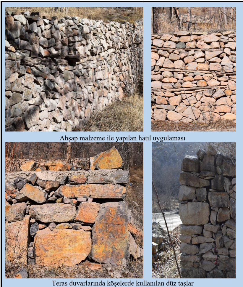
F. 4. Teras duvarlarında hatıl uygulaması
