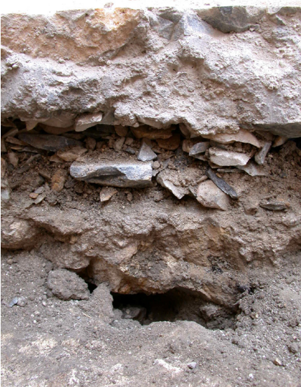
Resim 9 Tarsus Roma Hamamı opus sectile döşemesi alt yapısı detay fotoğrafı.
