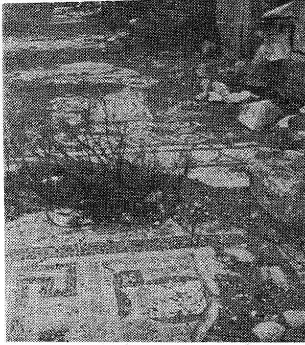
Res. 5 — Çatlak arasına giren bitki tohumunun büyümesi ve tahribatı.
