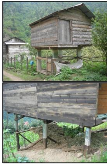
Foto 29-30-31- Ambar direklerinde dairesel taş kullanılmadığında direklere yerleştirilen sac sayesinde kemirgenlerin ambara ulaşması engellenmeye çalışılmaktadır (Kaynak: Leman ALBAYRAK- Cevdet YILMAZ) Photo 29-30-31- When circular stone is not used in warehouse poles, it is tried to prevent rodents from reaching the warehouse thanks to the sheet placed on the poles (Source: Leman ALBAYRAK- Cevdet YILMAZ)
