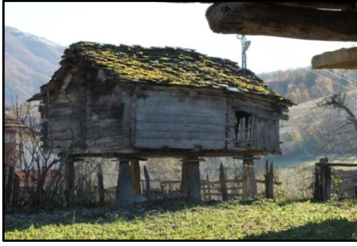
Foto 12-13- Türkiye ve İsviçre çatı örtüsü olarak taş malzeme kullanılan bir ambarlar (Caxigalinas, 2020). Photo 12-13- Warehouses using stone material as roof cover in Turkey and Switzerland (Caxigalinas, 2020).
