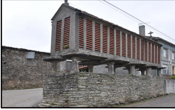
Foto 2-3- Uygun havalandırma şartları sağlanmış ambarlara İspanya (Foropicos, 2020) (solda) ve Türkiye'den (sağda) örnekler.
