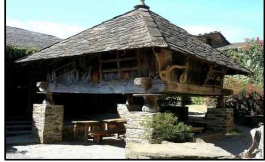
Foto 11- İspanya'da çatı örtüsü olarak taş malzeme kullanılan bir ambar (Caxigalinas, 2020).
