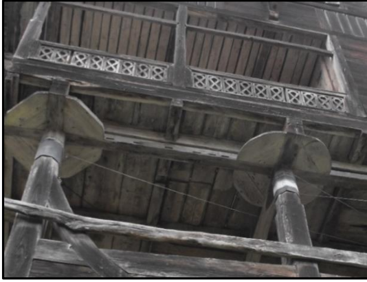
Foto 27-28- Ambarlarda kemirgen hayvanlara karşı kullanılan dairesel taşlara Türkiye'den, mantar şeklinde olanlara İspanya'dan örnekler (Radioviajera, 2019).
