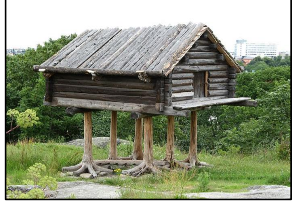
Foto 26- İsveç'te direkler üzerinde yükseltilmiş bir ambar (Wikimedia, 2020b).
