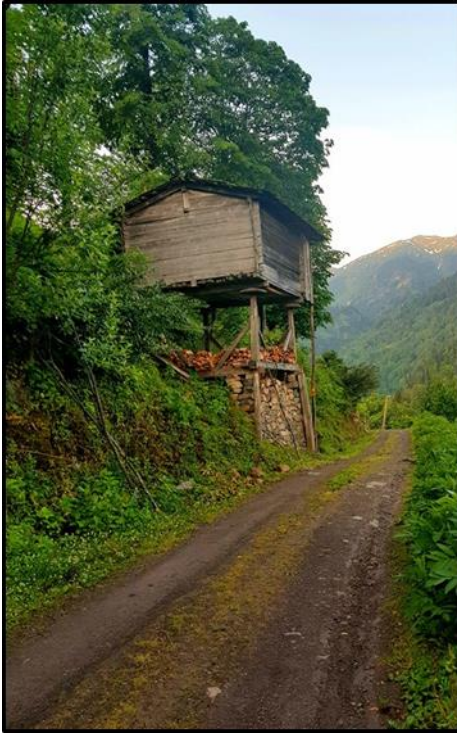
Foto 4-5-6. Türkiye'de (solda) (Leman ALBAYRAK) ve Portekiz'de (sağ üstte) (Caxigalinas, 2020) (sağ altta) (Atlasobscura, 2020) hava akımını en iyi alacak şekilde inşa edilen ambarlar.
