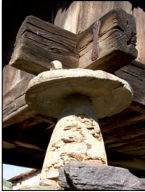
Foto 14-15-16- İspanya'da ahşap malzemenin bozulmasını önlemek için kullanılan sistemin (Pedrayes, Paredes and Barro, 2018) (Solda ve sağ üstte) Türkiye'de sac malzeme kullanılarak ahşap malzemenin korunması (Sağ altta).
