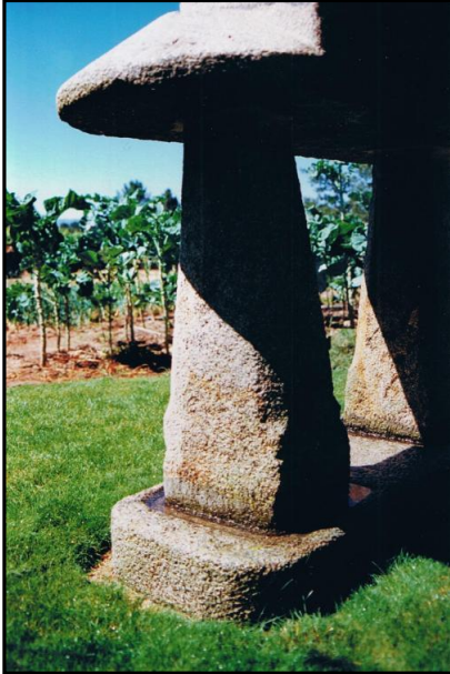
Foto 34- Bal üretilen ambarlara karınca vb. böceklerin ulaşmasını engellemek için yapılan ve içine su doldurulan kanal (Horreosdegalia, 2019).
