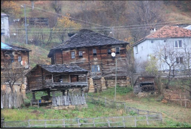
Foto 17- Aynı avlu içinde evle arasında mesafe bırakılarak inşa edilen bir ambar (Türkiye/Sinop) (Kaya ve Yılmaz, 2019).
