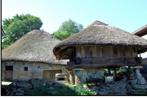
Foto 10- İspanya'da çatı örtüsü olarak saman kullanılan bir ambar (Kuriositas, 2020)
