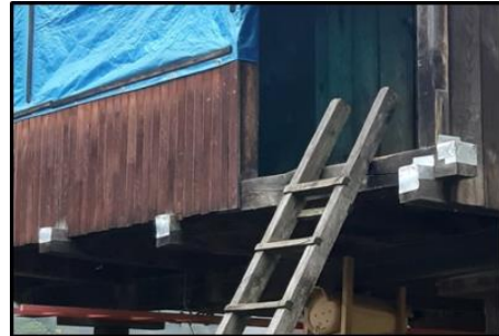
Foto 14-15-16- İspanya'da ahşap malzemenin bozulmasını önlemek için kullanılan sistemin (Pedrayes, Paredes and Barro, 2018) (Solda ve sağ üstte) Türkiye'de sac malzeme kullanılarak ahşap malzemenin korunması (Sağ altta).
