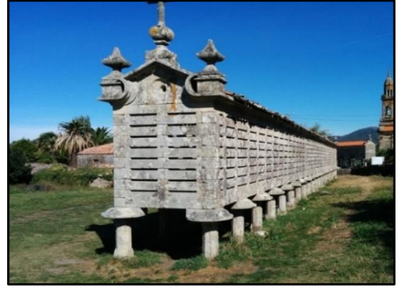
Foto 27-28- Ambarlarda kemirgen hayvanlara karşı kullanılan dairesel taşlara Türkiye'den, mantar şeklinde olanlara İspanya'dan örnekler (Radioviajera, 2019).
