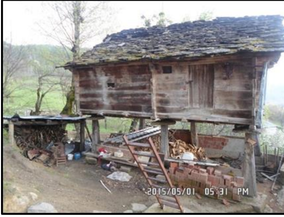
Foto 32-33- Kemirgenlerin veya yılanların ambara ulaşmasını engellemek için sürekli bir merdiven bulundurulmaz. Merdiven ihtiyaç duyulmadığında başka bir yerde saklanır ya da ambardan uzaklaştırılır.
