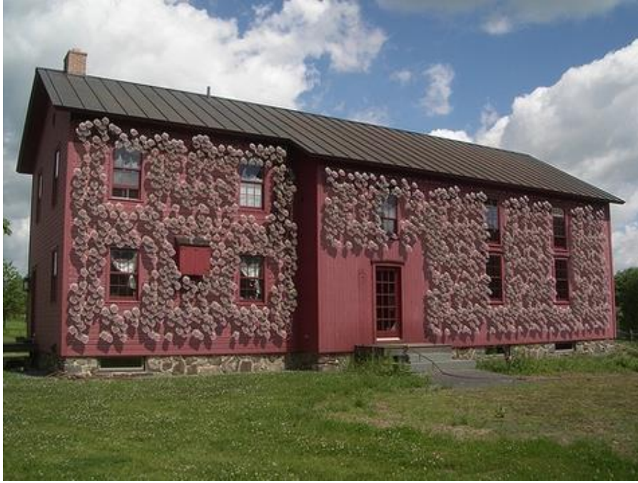
Şekil 5. 'Solar Ivy' fotovoltaik sistemi ile kaplanmış bir bina cephesi (Solaripedia, 2020a).
