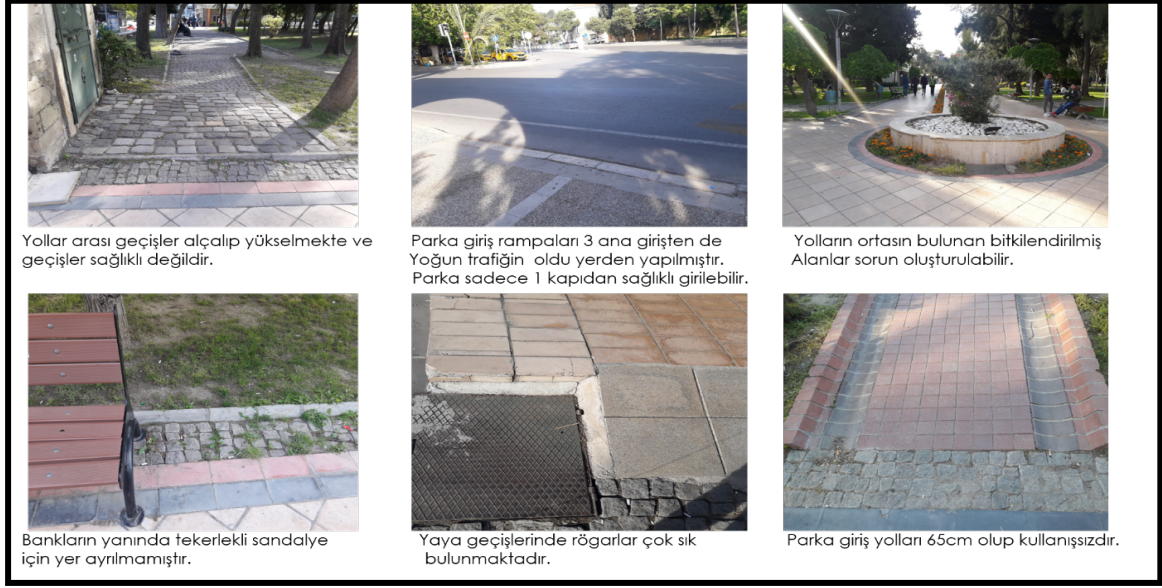
Şekil 3. Büyük Park içinde engelli bireylere uygun olmayan donatı elemanı örnekleri
