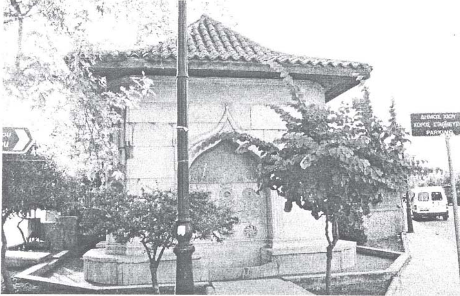
Resim 1: Sakız Adası Melek Mehmet Paşa Çeşmesi (güney cephe).
