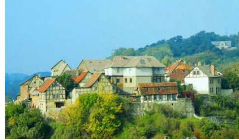
Şekil 27 : Quedlinburg Şehri (Url-29, 2018).
