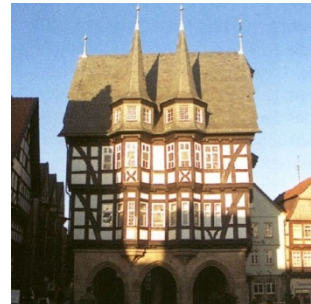
Şekil 25 : Alsfeld Belediye Binası (1512) (Bilici, 2006)
