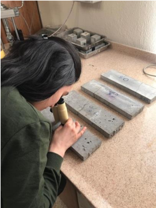
Şekil 3. PVA lif içeren harçlarda eğilme testi sonrası çatlak genişliği ölçümü (Measurement of crack width after bending test in PVA-containing mortars)
