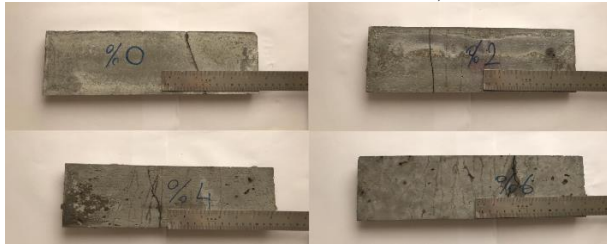
Şekil 7. PVA lifli harçların eğilme deneyi sonrası çatlak görünümleri (a: %0; b: %2; c: %4; d: %6) (Crack views of PVA fiber added mortars after bending test (a: 0%; b: 2%; c: 4%; d: 6%))
