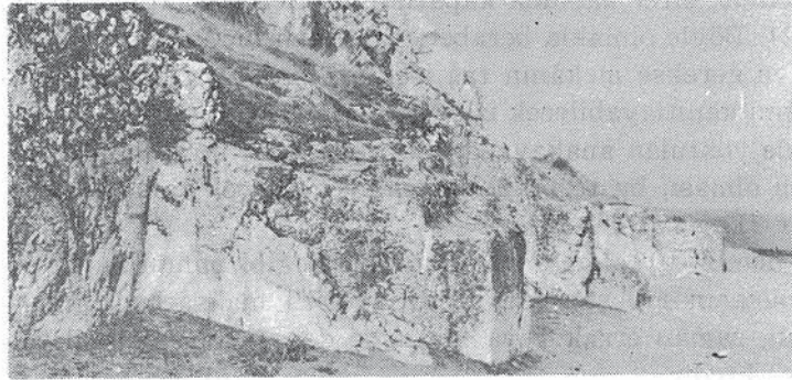
2. Kayaya işlenmiş tahkimli yol konstrüksiyonu, (Van kalesi, kuzeydoğudan).
