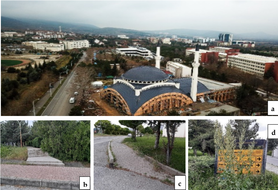
Şekil 11: İnönü Üniversitesi Kampüsü (a: kampüsün kuşbakışı görünümü b: yay yolu örneği c: yaya yolundaki bitki boyları d: kontrolsüz uzayan bitki örneği )
