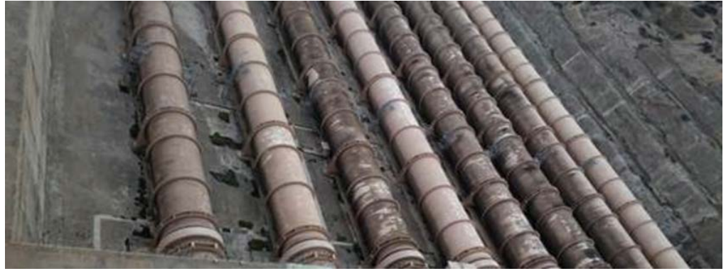
Şekil 10. Cebri borulardan görünüm
