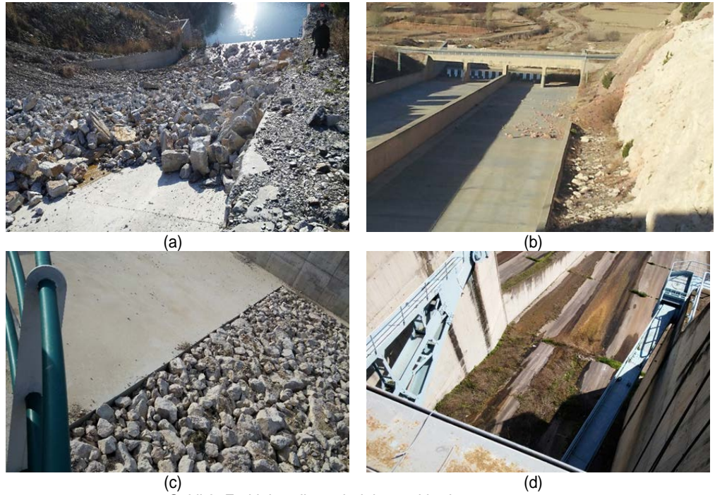
Şekil 8. Farklı barajlara ait dolusavaklardan görünüm
