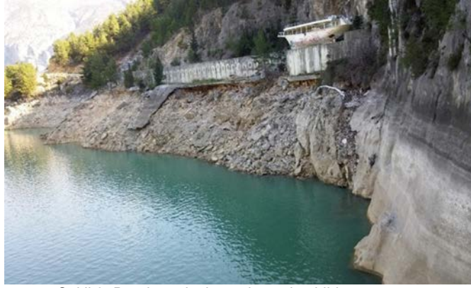
Şekil 9. Baraj gövdesine yakın sol sahilden görünüm
