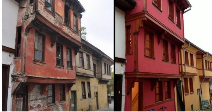
Şekil 5. Bey Konakları öncesi ve sonrası durumu (restorasyonforum.com)
