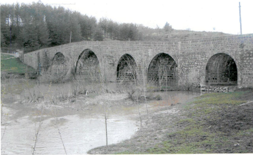
Resim 2 - Devegeçidi Köprüsü Genel Görünüşü
