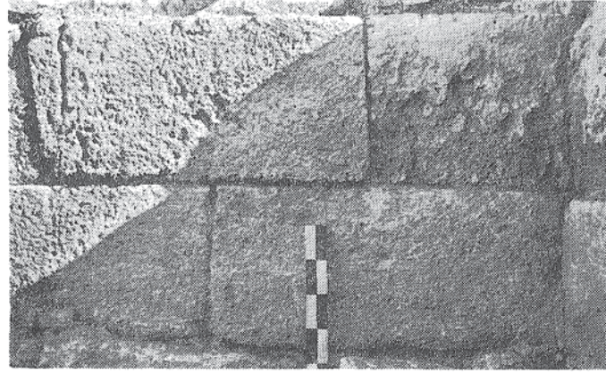
2. Cella taş duvar işçiliğinden detay.
