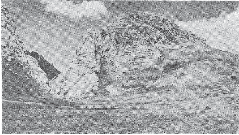
3 Yeşilalıç kalesinin genel görünüşü. 3 General view of Yeşilalıç fortress.
