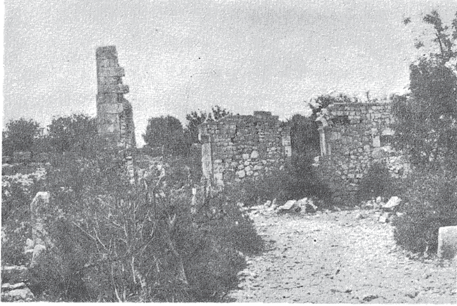
Res. 21 — III. No.lu basilika güney cephesi.
