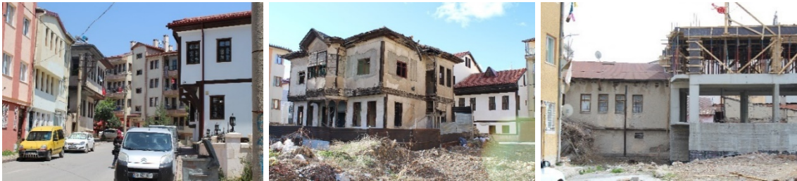
Şekil 25: Sivas geleneksel evlerinde çevresel koruma sorunları (sırasıyla: yoğun yeni yapılaşma; metruk kalan geleneksel konutlar; yeni yapılaşmanın geleneksel konutlara baskısı) (Gülhayat Kılıcı)
