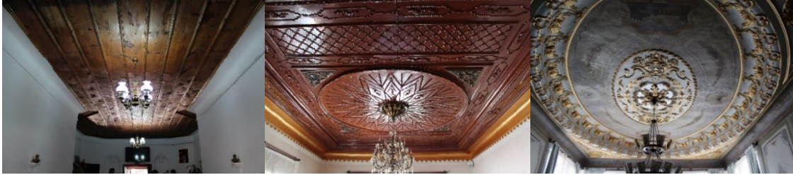
Şekil 16: Sivas konutlarında tavan kaplaması örnekleri sırasıyla: çıtalı ahşap tavan, göbekli ahşap oyma tavan ve alçı kaplama tavan (Gülhayat Kılıcı)
