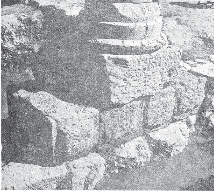
1. Létôon. Parement interne du socle en calcaire dur et assises de boutisses en calcaire tendre d'une section de péribole Est-Ouest.
