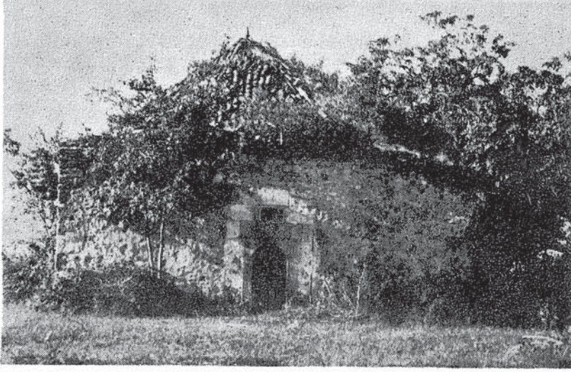
1 Giriş - Güney Cephesi.
