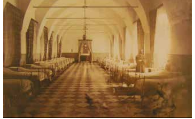
Fotoğraf 18. College de Terre Saint (Terre Saint Koleji)'in yatakhaneli (Fotoğraf: Yapıda bulunan görsel, yazar tarafından fotoğraflanmıştır, Ekim, 2005). / The dorm space of College de Terre Saint in Aleppo.
