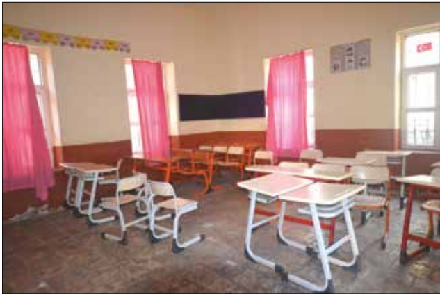
Fotoğraf 8. Kesme taş zemin döşemeli sınıf (Rifaioğlu, M. N., 2019). / Classroom with fine cut stone floor covering.
