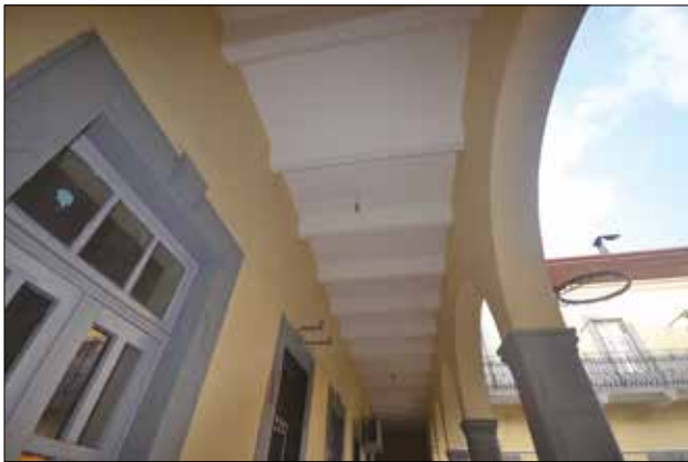
Fotoğraf 5. Revaklı cephenin tavanında bulunan pütreller. (Rifaioğlu, M. N., 2019) / I beams and the ceiling of the portico.
