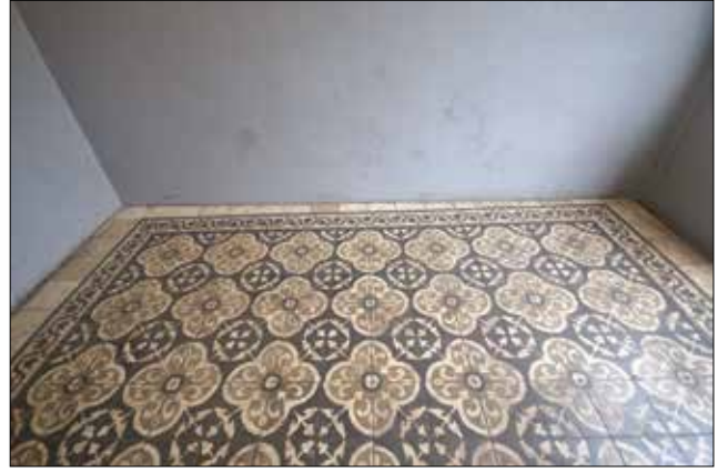
Fotoğraf 9. Karosiman zemin döşemesi (Rifaioğlu, M. N., 2019) / Cement tile floor covering.
