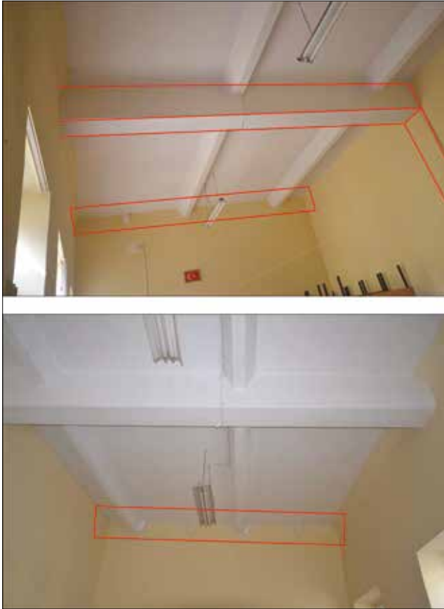
Fotoğraf 22. Birinci dönemde var olmayan kütlede yer alan betonarme kirişe oturan putreller ve duvarda kesilmiş putrel izleri (Rifaioğlu, M. N., 2019) / The traces of I beams.
