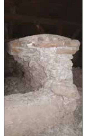
Fotoğraf 24. Yığma parapet duvarı. (Rifaioğlu, M. N., 2019) / Masonry roof parapet.
