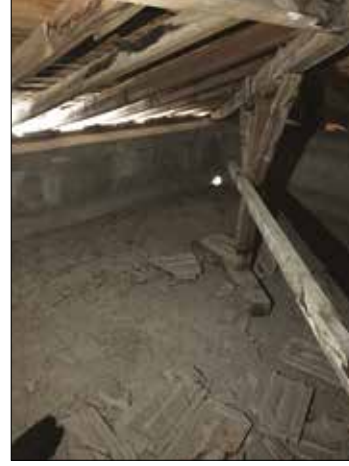
Fotoğraf 23. Çatı arası ve çatı parapeti. (Rifaioğlu, M. N., 2019) / Attic and roof parapet.
