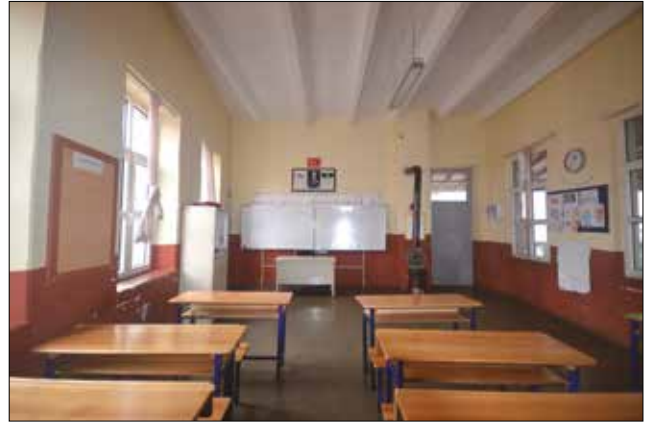
Fotoğraf 10. Beton şap zemin döşemeli sınıf (Rifaioğlu, M. N., 2019). / Classroom with concrete screed floor covering.
