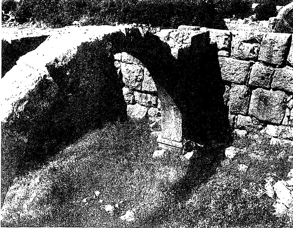
Resim 7: 4 No.lu ev, birinci mekandaki taşıyıcı kemer
