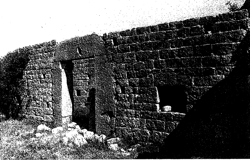
Resim 6 : 4 No.lu ev, avlu ile evi ayıran duvar
