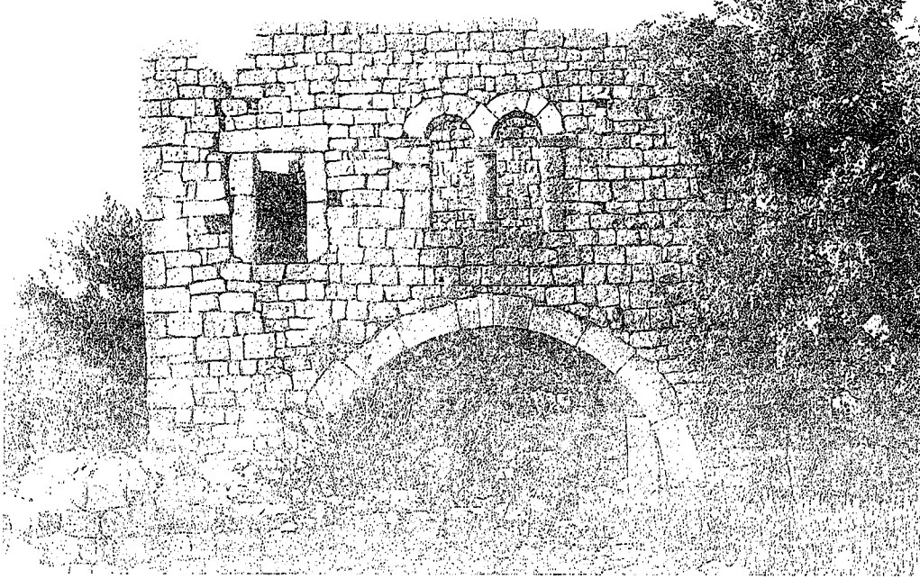
Resim 9 : 5 No.lu ev, güney cephesi
