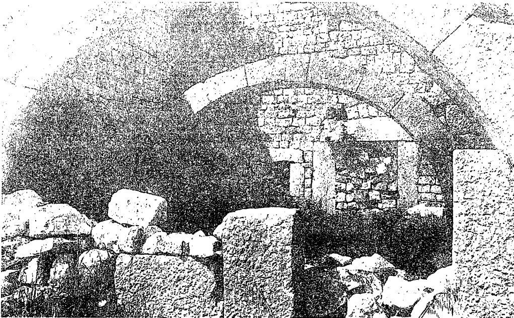
Resim 10 : 5 No.lu ev, taşıyıcı kemer
