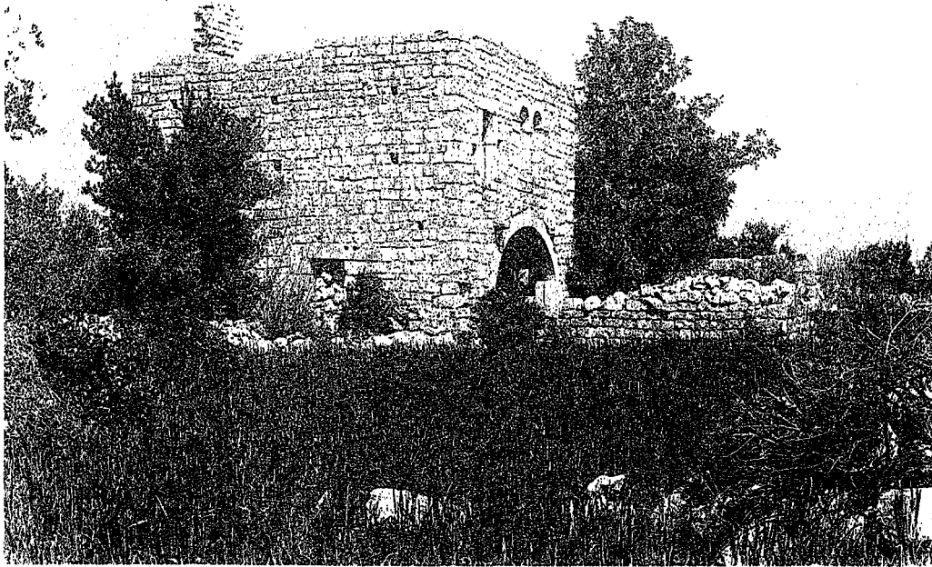
Resim 8 : 5 No.lu ev, genel görünüm
