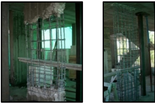
Şekil 4. Kolonlarda hasarlı bölgenin çıkartılması
