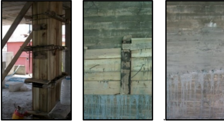
Şekil 5. Hasarlı olan bölgelerde beton kalıbı ve beton yerleştirilmesi
