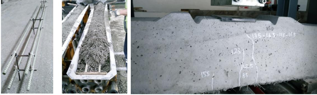
Şekil 7. 18 mm çapta 4 adet yerli GFRP donatılı traversin üretim ve test aşamaları
