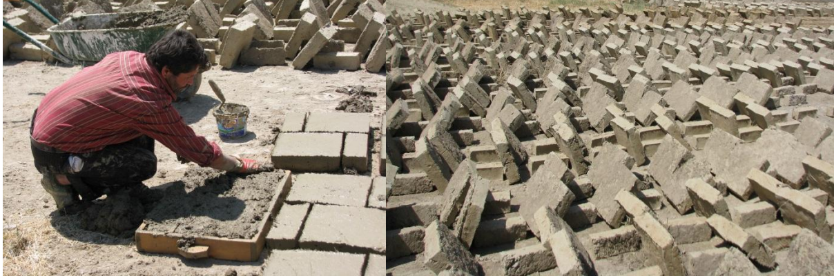
Şek. 24, 25: Kerpiç Yapım Görünüşleri (Ş. Öztürk-2005)
