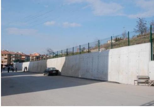
Şekil 10. Çevre istinat duvarından bir görünüm
