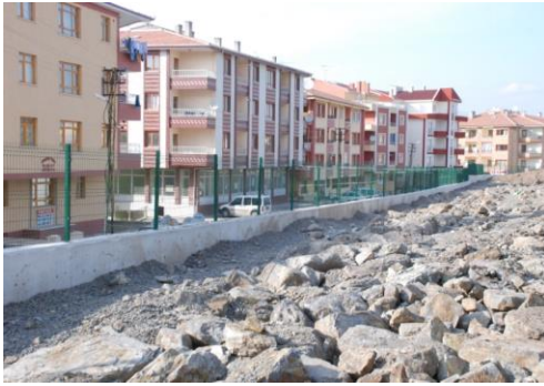
Şekil 12. Yıldırım Beyazıt Parkı istinat duvarının dolgu malzemesi ile desteklenmesi
