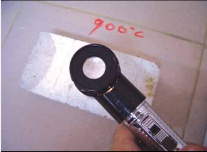
Şekil 11. Çatlak genişliğinin ölçülmesi.
