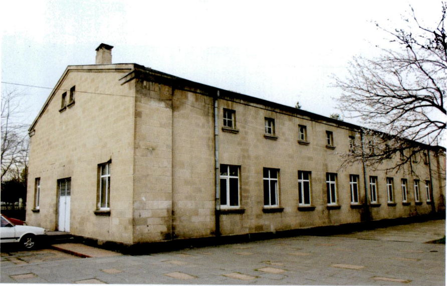
Resim 56 - Kayseri Erkek Sanat Okulu tesviye atölyesi dıştan görünüşü.
