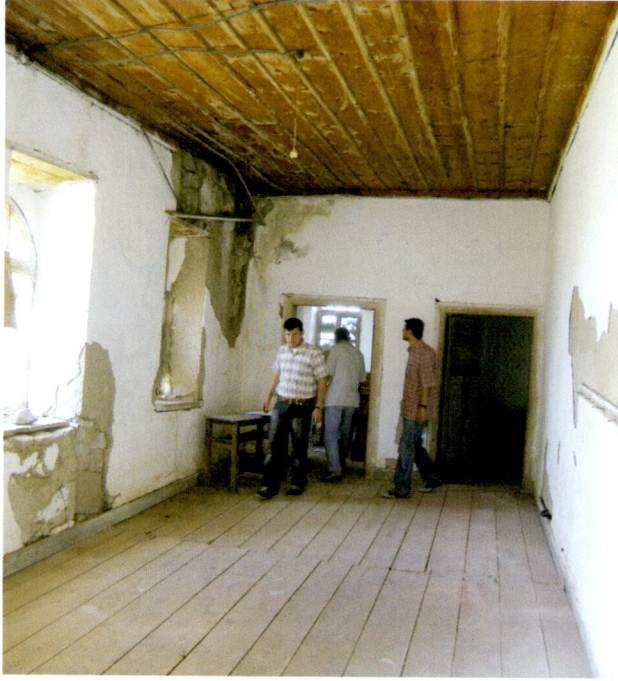
Resim 18 - Artmak Köyü İlkokulu giriş koridorundan görünüşü.
