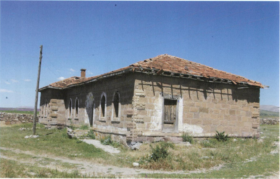
Resim 15 - Artmak Köyü İlkokulu güney ve batı cepheden genel görünüşü.
