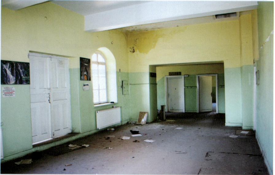
Resim 11 - Kayseri Safa Mektebi giriş koridoru ve ek binaya geçiş veren açıklık.
