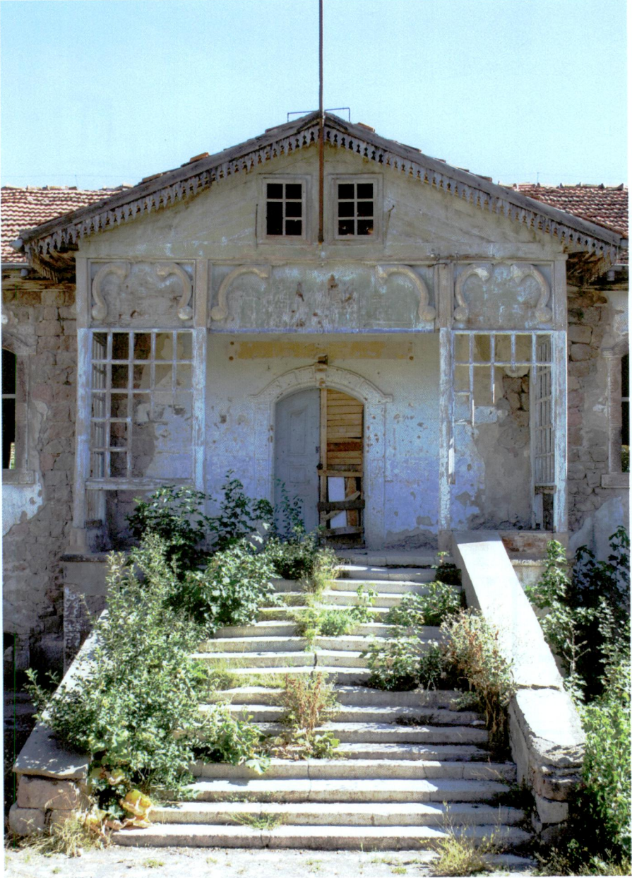
Resim 44 - Pazarören Köy Enstitüsü (Öğretmen Okulu) giriş revağı ve kapısından görünüş.
