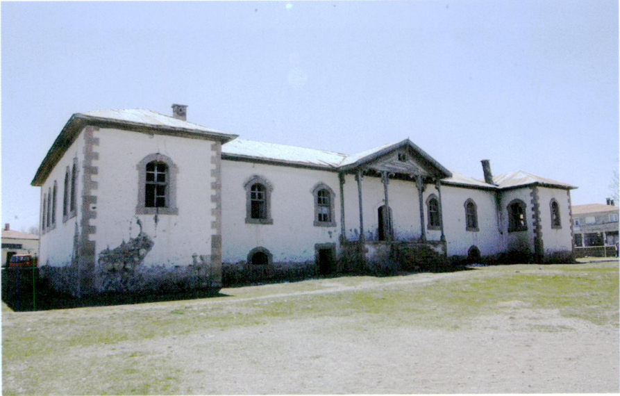
Resim 38 - Kaynar Kasabası İlkokulu giriş cephesinden (kuzey) görünüşü.
