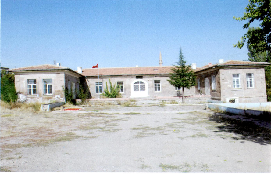
Resim 30 - Kızık Köyü İlkokulunun giriş cephesinden genel görünüşü
