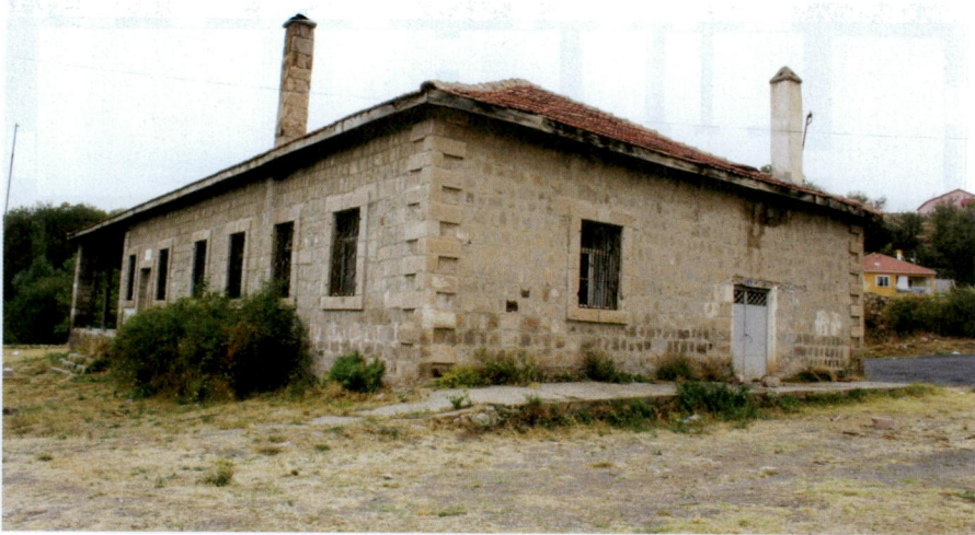
Resim 59 - Nize (Güzelköy) Köyü İlkokulunun kuzey ve batı cephelerinden görünüşü.
