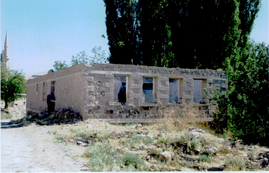
Resim 63 - Turan (Dimitre) Köyü İlkokulu genel görünüşü.
