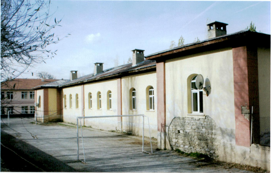
Resim 34 - Akkışla Cumhuriyet İlkokulu arka (güney) cephesinden görünüş
