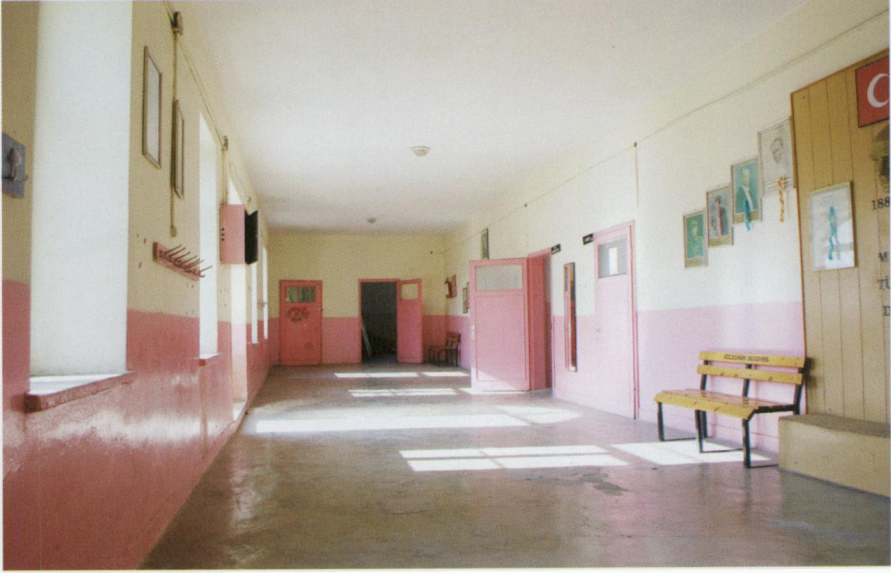
Resim 32 - Kızık Köyü İlkokulu giriş koridorunun görünüşü
