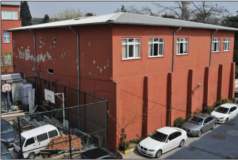
Eski Siklotron Binası'nın (bugün, SBMYO B Binası'nın bir kısmı) Eczacılık Fakültesi C Blok'un 3. katından (Farmasötik Botanik ABD) görünümü; pencere kat sonradan eklenmiştir. (Fotoğraf: Kaan Ata, 02.04.2014)
