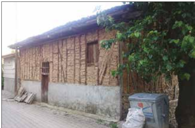
Fotoğraf 40. Cephede çimento sıva uygulaması (E-101) (Yıldız, 2017) / Cement plaster on the facade
