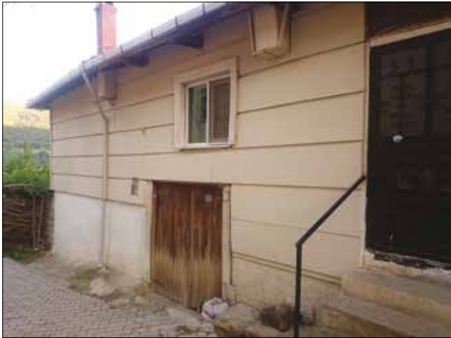
Fotoğraf 56. Geleneksel yapıda mantolama (Yıldız, 2017) / Sheating practice sample on a traditional building
