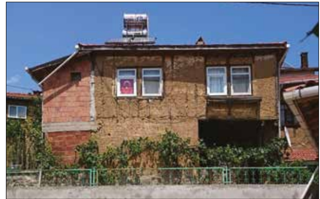
Fotoğraf 48. Geleneksel yapıya iki katlı ek (Yıldız, 2017) / Two-storey addition to traditional building
