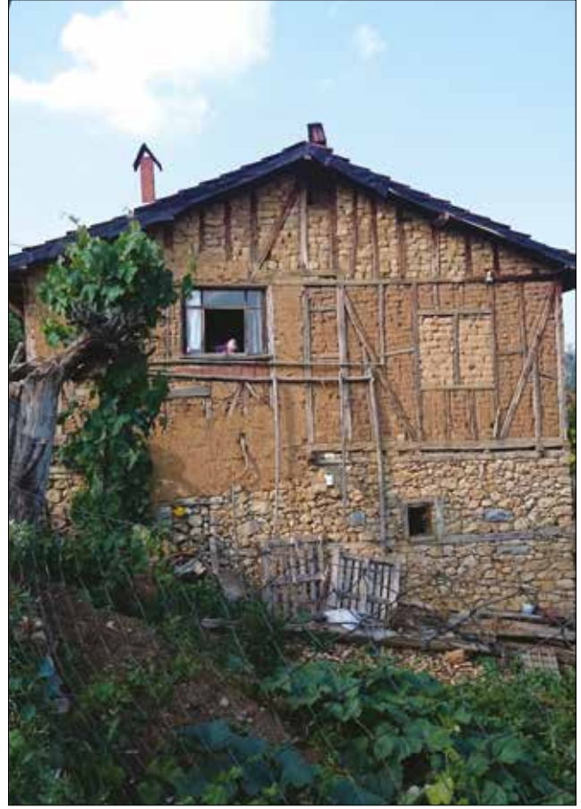
Fotoğraf 52. Değiştirilen ve kapatılan pencereler (E-59) (Yıldız, 2017) / Changed and destructed window examples
