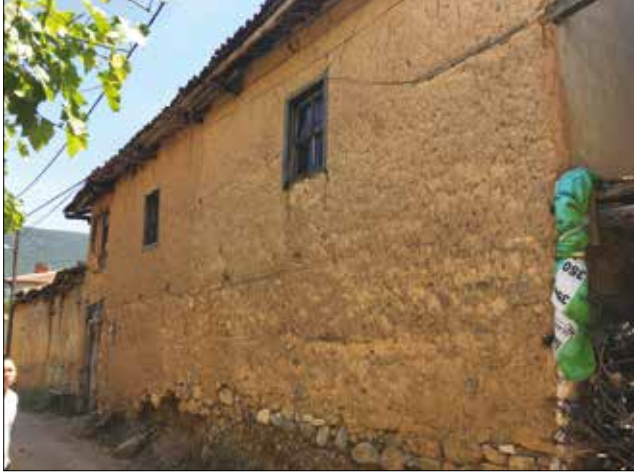
Fotoğraf 54. Yol çalışmaları sırasında tahrip olan beden duvarı (E-107) (Yıldız, 2017) / Destructed mainwall sample during road works
