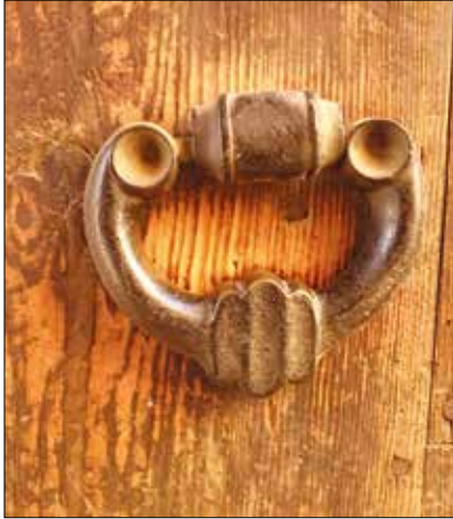
Fotoğraf 32. Giriş kapısında bulunan metal tokmak (E-110) (Yıldız, 2017) / Metal mallet on entrance door
