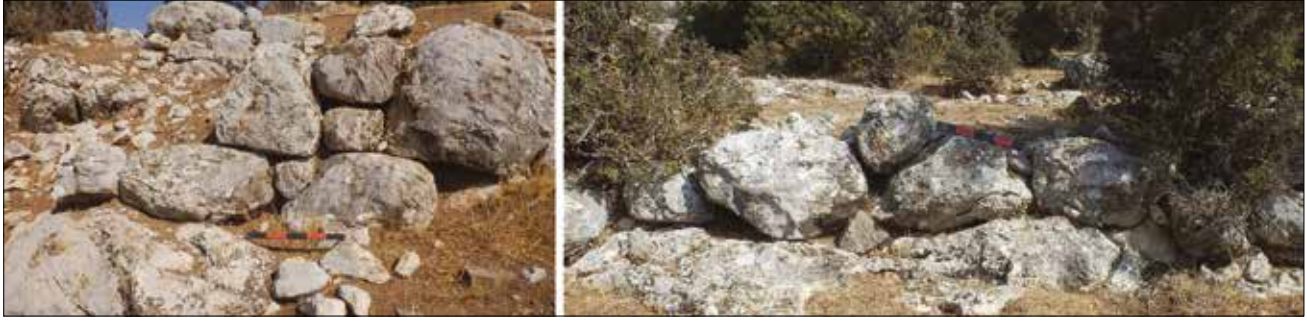
Fotoğraf 7 - Sivrikaya Kalesi bazı teras duvarı cepheleri. / Facade of the some terrace walls at Sivrikaya.
