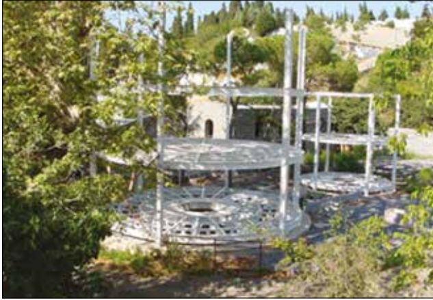
Fotoğraf 4: Kuzguncuk Gazometresi'nin yeniden inşa sürecindeki durumu (Url 5). / Kuzguncuk Gasometer during the rebuilding process (Url 5).
