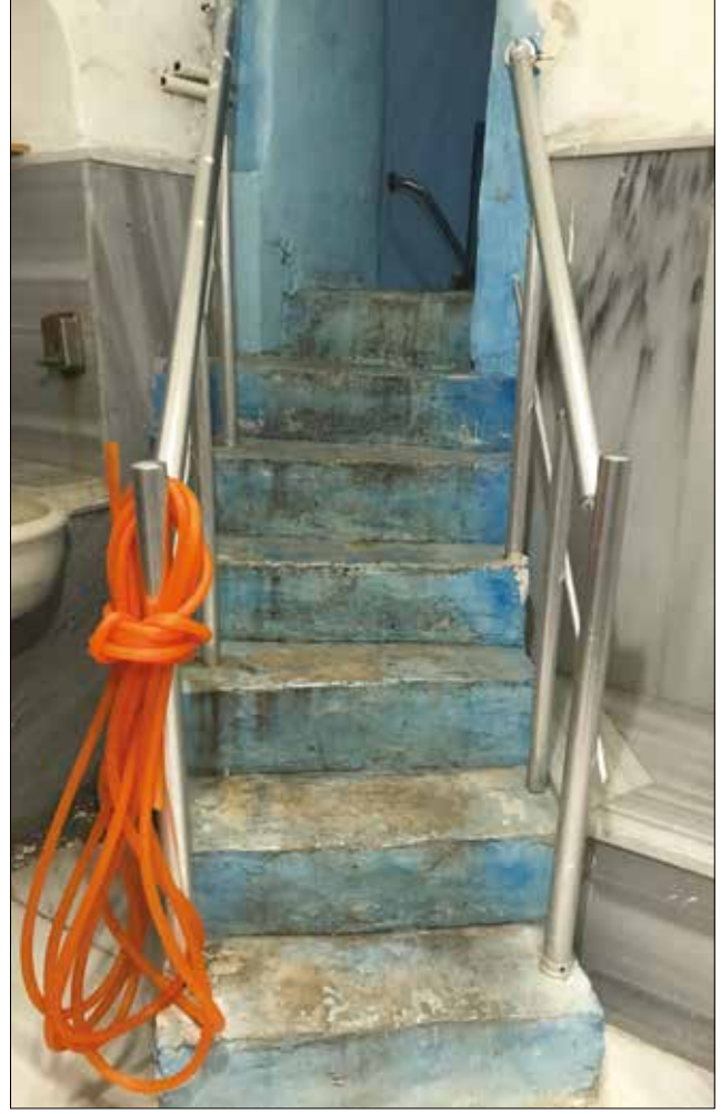
Fotoğraf 26. Hamam ılık kısmından havuza çıkışı sağlayan muhdes merdiven / The later added staircase that provides the connection between the pool and the hammam's warm section (Canutez, 2018)
