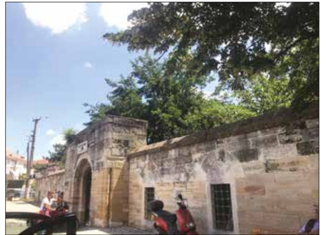
Fotoğraf 18. Kuzey avlu girişi dış görünüşü / External view of the north courtyard entrance (Canitez, 2018)
