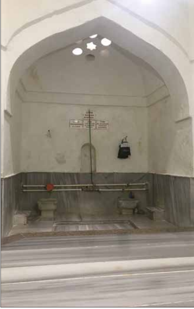
Fotoğraf 25. Hamam sıcaklık kısmında yapılan müdahaleler ve nem sorunu / The interventions made in the hammam's hot section and the humidity problem (Canutez, 2018).
