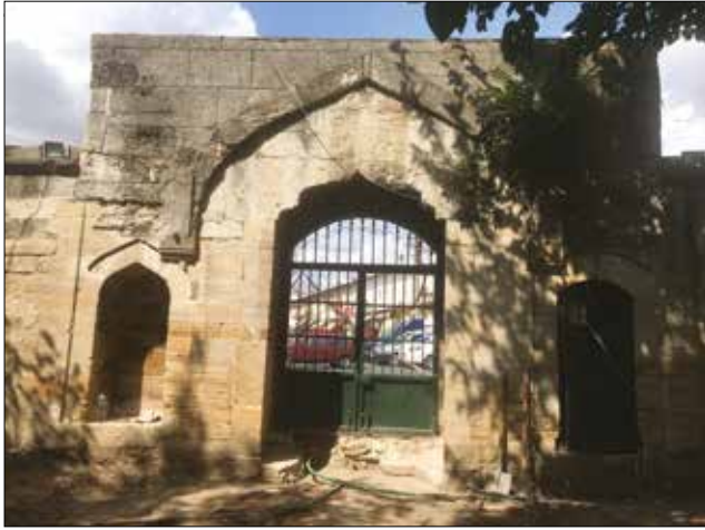
Fotoğraf 19. Kuzey avlu girişi iç görünüşü-revak kalıntıları / Internal view of the north courtyard entrance - remains of the portico (Canitez, 2018)
