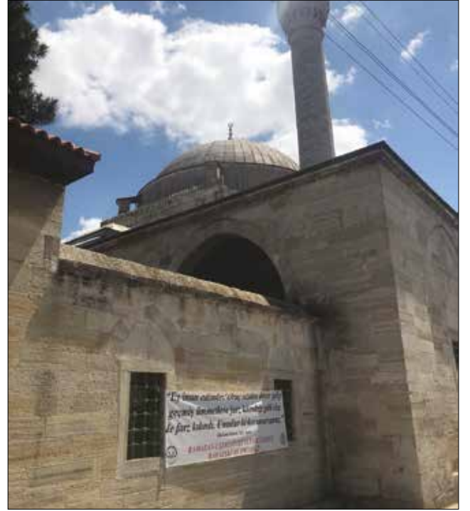
Fotoğraf 17. Batı avlu duvarı ile son cemaat mahali bağlantı detayı (muhdes bir uygulamayı işaret etmekte) / Detail of the connection between the west courtyard wall and the latecomers' area (It indicates a later addition) (Canitez, 2018)
