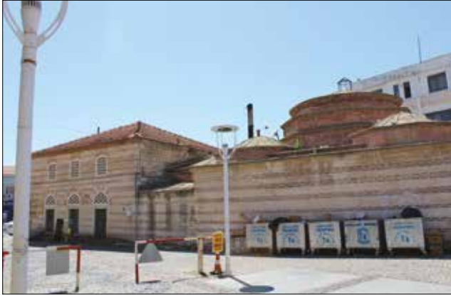
Fotoğraf 20. Hamam, doğu cephe / Hamam's east facade (Canitez, 2018).
