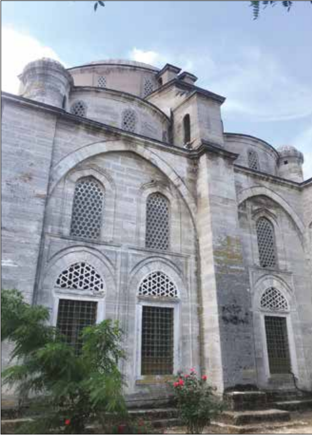
Fotoğraf 4. Cami doğu cephesi / The mosque's east facade (Cantez, 2018).
