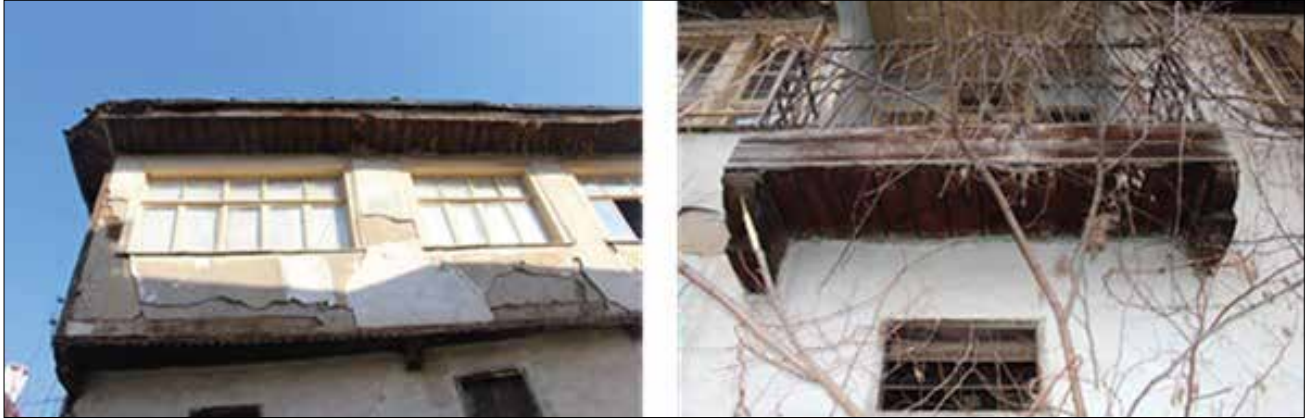
Fotoğraf 24. Yapıya ait çıkımlar / The consoles belonging to the building (A.K. Ercan Arşivi)
