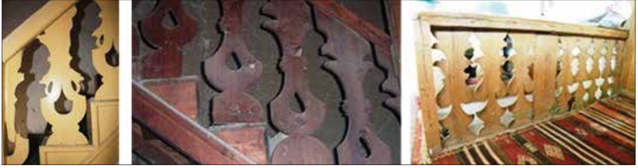
Fotoğraf 17. Vasfî Süsoy Evi, Plevne Müzesi ve Bey Sokak'ta bulunan korkuluklar / Railings at Vasfî Süsoy House, Plevne Museum and Bey Street (E.S.Akın Arşivi)
