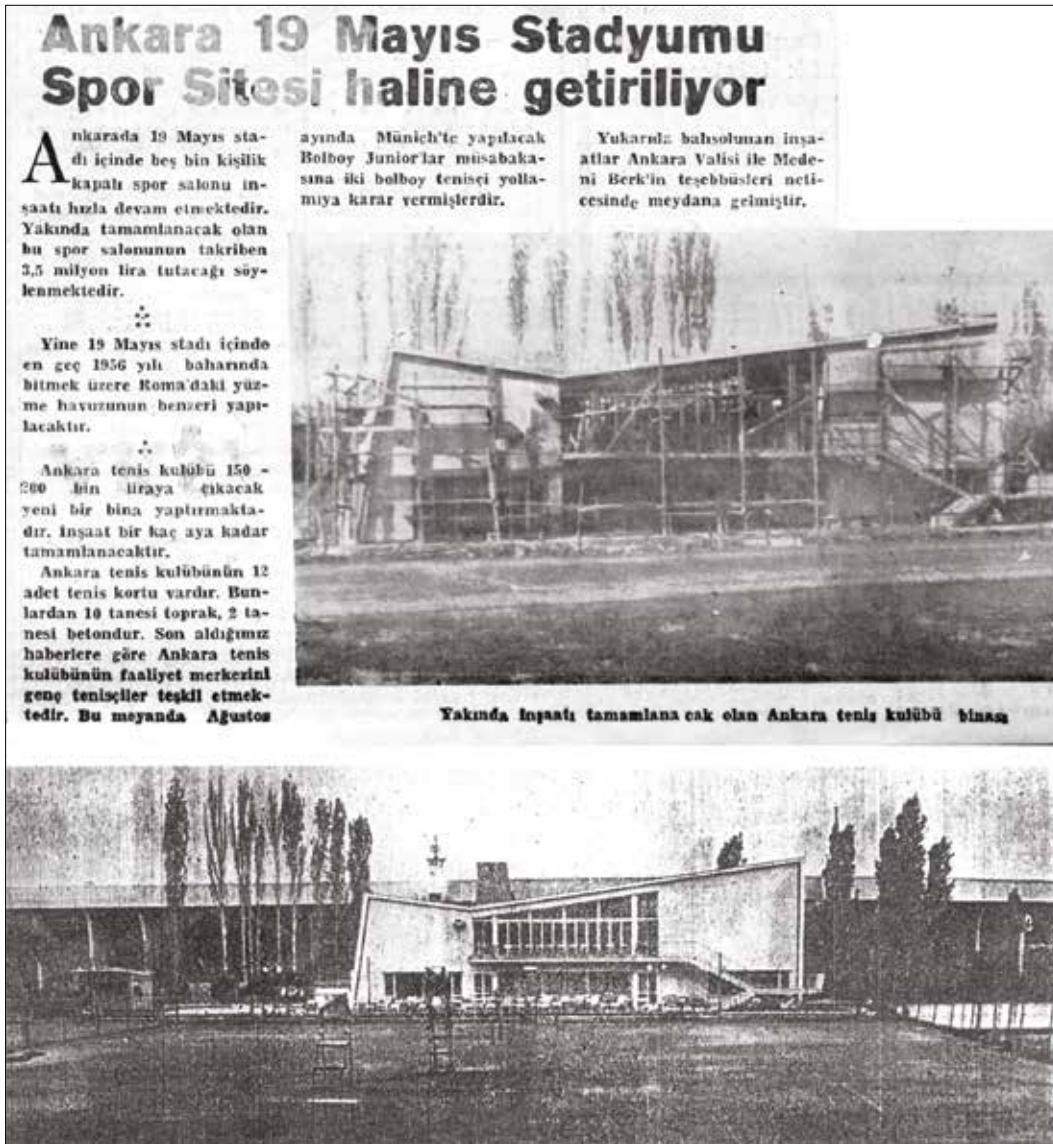
Figure 16 - Ankara Tennis Club under construction, and in 1957 (Akşam 01.06.1955; Büyük Ankara'ya Doğru 1957) / Ankara Tenis Kulübü binası inşaat halindeyken ve 1957'de.
