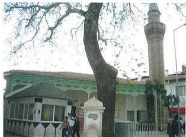
Res. 4. Mahkeme Camisi (env. no: İ17.B11.42), Hacı Tuğrul Mahallesi.
