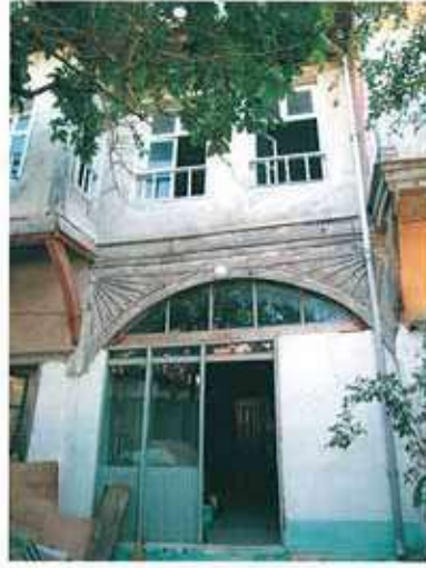
Res. 7. Dış cephesi.
