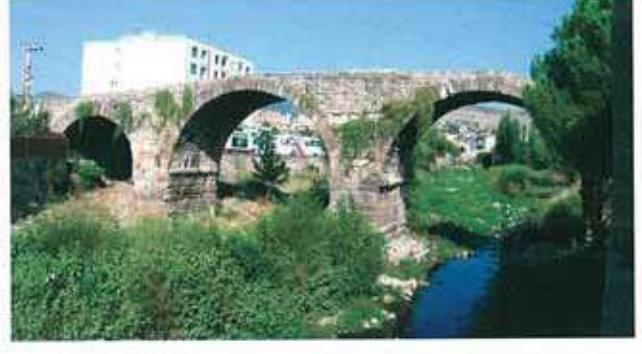
Res. 43. Üç Kemer Köprüsü (env. no: J18.B5.1120).
