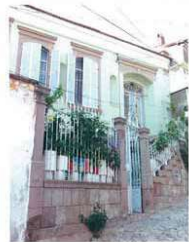
Res. 17. Aynı evin dış cephesi.
