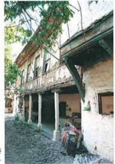
Res. 4. Evin dış görünüşü.
