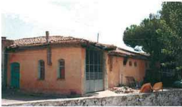
Res.30. Eski hâl binası (env. no: J18.B5.1658).
