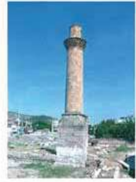
Res. 37. Emirsultan Minaresi (env. no: J18.B5.1226).
