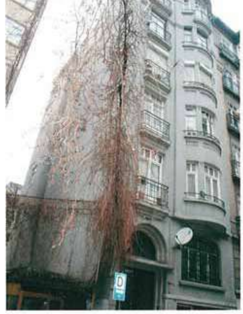
Res. 2. Şimşirci Sokağı no. 11, (env. no: F21.B10.113)
