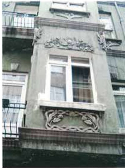
Res. 6. Havyar Sokağı no. 6-8, (env. no: F21.B10.88).
