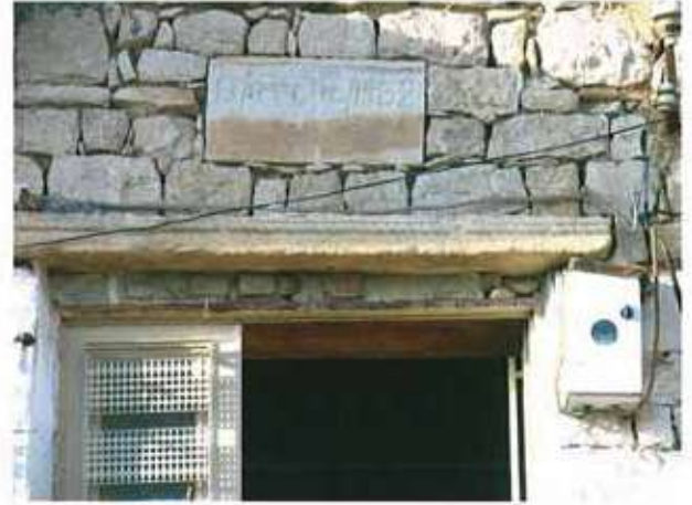
Res. 53. Kapı kirişi olarak kullanılan bir Antikçağ yapı elemanı ve hemen üzerinde yapının (env. no: O30.B7.245) 1952 tarihli yapım kitabesi.
