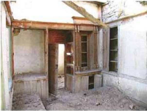
Res. 39. Genelde sofa ve odaları duvar yerine yaklaşık 70 -100 cm derinliğinde ahşap dolaplar ayırır. (O30.B7.187 envanter numaralı konut.)
