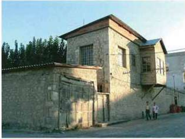
Res. 18. Kale Mahallesi, Devenci Caddesinden yer alan ahşap çıkmalı kârgir bir yapı (env. no: O30.B7.427).
