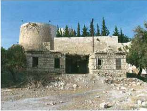
Res. 22. Geleneksel konut dokusu Mut Kalesinden başlayarak gelişmiştir. Genelde tek ya da iki katlı yapılar taş malzeme ile yığma kargir sistemde inşa edilmişlerdir (env. no: O30.B7.189).
