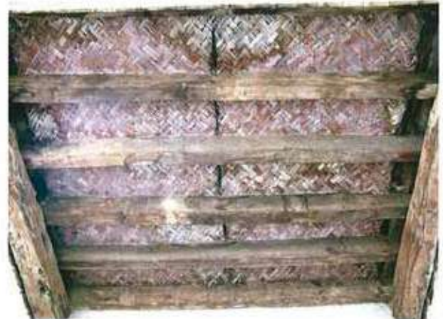
Res. 47. Çapa adı verilen dikdörtgen kesitli kirişlerin açıkta bırakıldığı ve altından hasırların gözüktüğü tavan ayrıntısı. (O30.B7.66 env. numaralı konut.)
