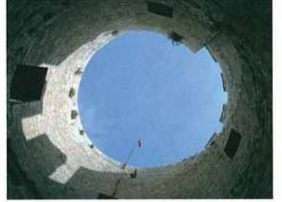
Res. 4. Mut Kalesinin en yüksek noktasında bulunan dolayısıyla gözetleme kulesi işlevi gören Dizdar Kulesinin (env. no: O30.B7.91) içerden ayrıntısı.
