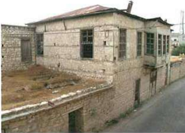
Res. 24. Beden duvarlarının kaba yonu taş malzeme ile yığma kargir yapım tekniğinde inşa edildiği bir konut örneği (env. no: O30.B7.21).
