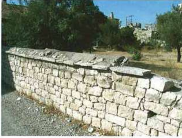
Res. 28. Bir konutun (env. no: O30.B7.43) bahçe duvarından ayrıntı. Bahçe duvarlarının saçak vazifesi gören ve "çeleni" adı verilen bitiminde, "say taşı" adı verilen, yaklaşık 3 cm kalınlığında, 15-30 cm uzunluğundaki yassı taşların kullanılmıştır.
