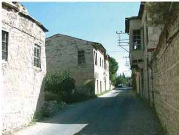
Res. 20. Doğancı Mahallesi, Erden Sokak. Genelde parselin yola bakan yüzünde konumlanmış yapıların ahşap çıkmaları yol-yapı ilişkisini arttırmıştır.
