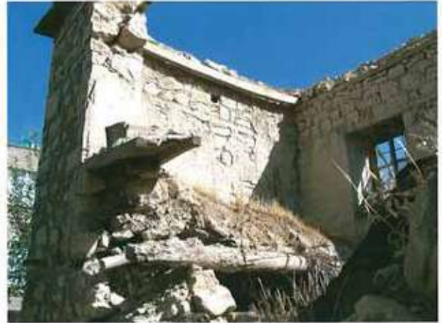
Res. 23. Beden duvarlarında, yaklaşık 50-150 cm'de bir ahşap hatıl kullanılmıştır. Harap bir yapıda (env. no: O30.B7.73) görülebilen, "köstek" adı verilen bu hatıllar, duvarın iç ve dış yüzeyine birer adet yerleştirilir ve birbirlerine hatıl boyunca tekrarlanan ince ahşaplarla tespit edilir.
