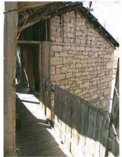
Res. 27. Ana yapı (env. no: O30.B7.185) ile bağlantıyı sağlayan ahşap köprü.
