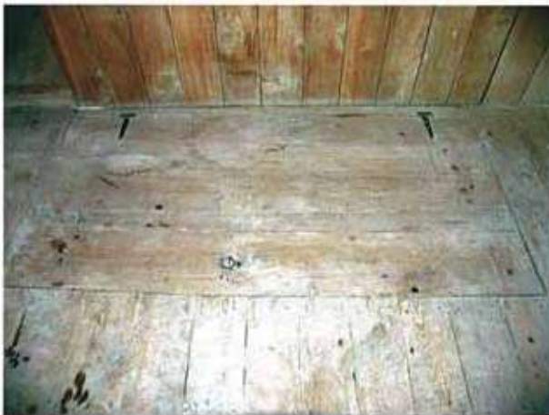
Res. 48. Sofaya çıkan merdivenin üstü ahşap kapak ile kapatılarak döşemenin kesintisiz hale getirildiği bir örnek (O30.B7.419 env. numaralı konut.)
