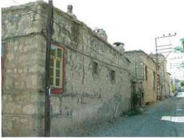
Res. 16. Kale Mahallesi Baykuş Sokak, kuzeyden güneye bakış.
