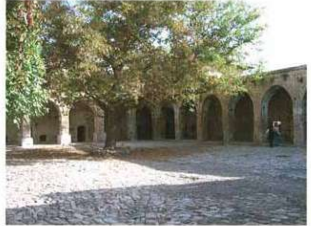
Res. 13. Taş Hanın (env. no: O30.B7.112) özgün plan şemasına göre 39 odası vardır. 30.5x20.0 m boyutundaki avluyu, sivri kemerli ve tonoz örtülü bir revak kuşatmaktadır.
