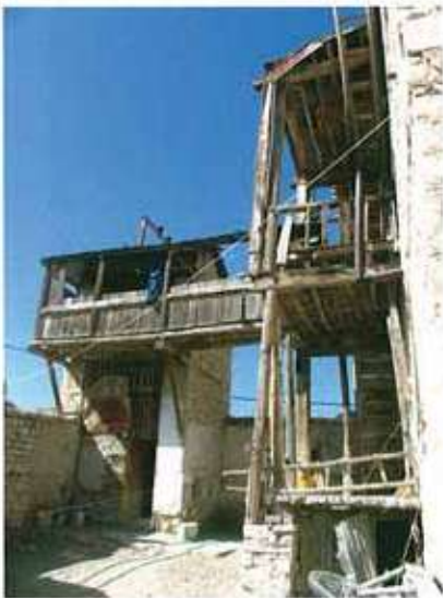
Res. 26. Evin (env. no: O30.B7.185) dışında bağımsız bir birim olarak inşa edilen ve alt katı hela, depo olarak kullanılan yapı.
