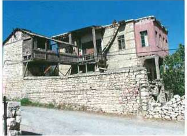
Res. 25. Depo, mutfak, banyo, hela gibi hacimleri evin dışında bağımsız bir birim olarak inşa edilen ve dış köprü ile ana yapıya bağlanan bir konut örneği (env. no: O30.B7.185).
