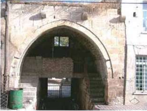
Res. 12. Taş Hanın (env. no: O30.B7.112) güney cephesinde, ana kütlede öne çıkartılmış taç kapı karakterindeki giriş kapısı bulunmaktadır.
