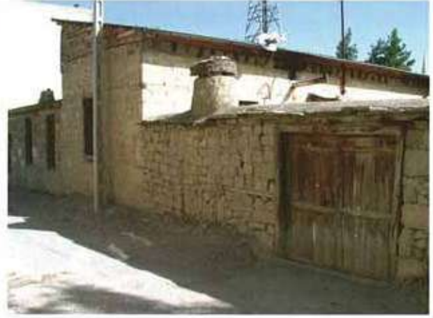
Res. 29. Bir konutun (env. no: O30.B7.150) bahçe duvarı, ahşap kapı ve bacası ayrıntısı. Düz toprak damlar düzenli bakım ve onarımlarının zorluğu nedeniyle yerlerini metal üst örtülü kırma ya da tek yöne eğimli çatılara bırakmıştır.
