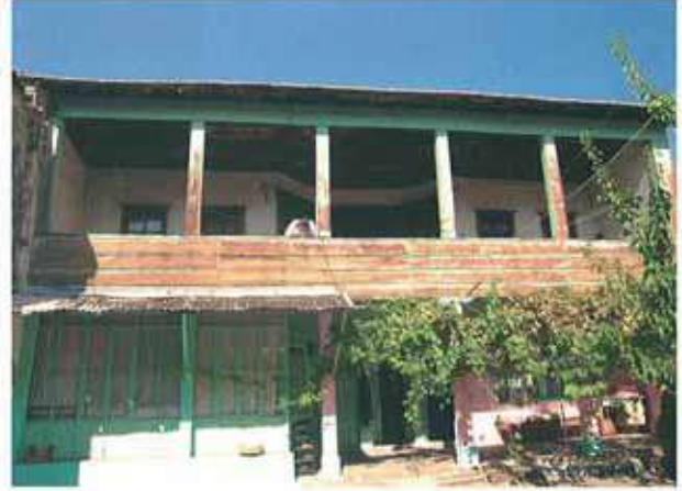
Res. 54. Selçuk Mahallesi 414 ada, 40 parselde bulunan konut (env. no: J18B0137).
