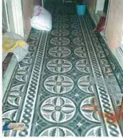
Res. 68. Talatpaşa Mahallesi 456 ada, 41 parselde bulunan konutun (env. no: J18B0081) zemin kat döşeme ayrıntısı.
