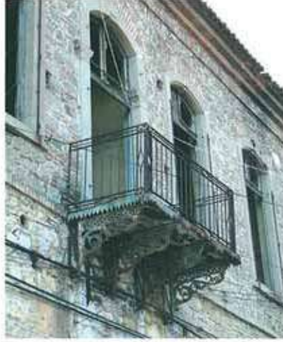
Res. 60. Talatpaşa Mahallesi 452 ada, 11 parselde bulunan Eski Türk Ocağı binasının (env. no: J18B0002) balkonu.
