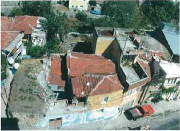
Res. 36. Barbaros Mahallesi, 299 ada, 15 parselde bulunan Tabaklar Hamamı (env. no: J18B0121).
