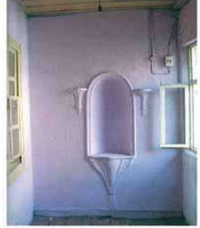
Res. 69. Talatpaşa Mahallesi 455 ada, 10 parseldeki konutun (env. no: J18B0023) sofasından ayrıntı.
