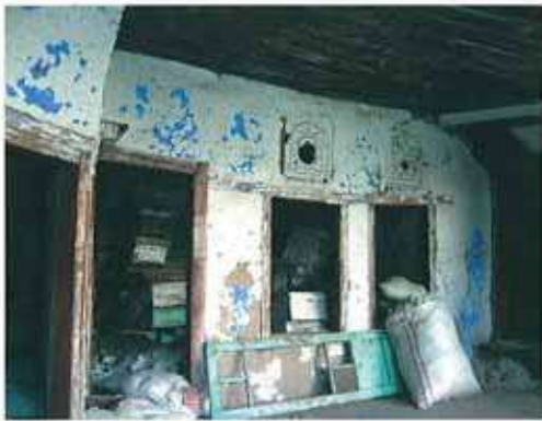
Res. 8 - 9. Evin birinci katında bulunan, "pahtı" duvarlarla çevrili dış sofanın, buraya açılan kapılar ve "revzen" tepe pencereleriyle günümüzdeki durumu.
