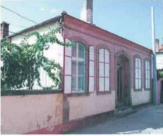
Res. 28. Ulucami Mahallesi 651 ada, 15 parselde bulunan evin (env. no: J18B0108) sokak cephesi.
