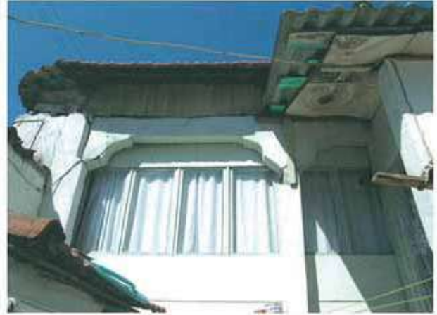
Res. 56. Selçuk Mahallesi 414 ada, 47 parselde bulunan konut (env. no: J18B0140).
