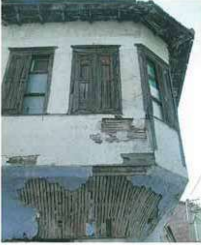
Res. 59. Talatpaşa Mahallesi 455 ada, 11 parselde bulunan konutun (env. no: J18B0024) cephesinden ayrıntı.
