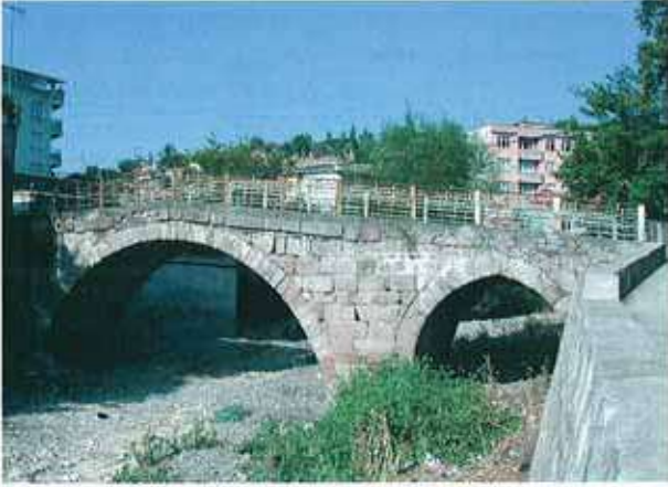
Res. 34. Barbaros Mahallesi ile Talatpaşa Mahallesi'ni bağlayan Ulucami Köprüsü (env. no: J18B0119).
