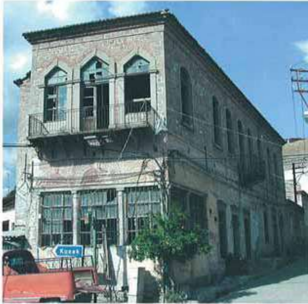
Res. 42. Talatpaşa Mahallesi 452 ada, 11 parseldeki eski Trk ocağı firması (env. no: J18B0002) gnmzde boş duruyor.
