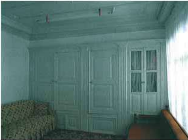
Res. 72. Selçuk Mahallesi 413 ada, 53 parselde bulunan konutun (env. no: J18B0125) iç mekânından ayrıntı.
