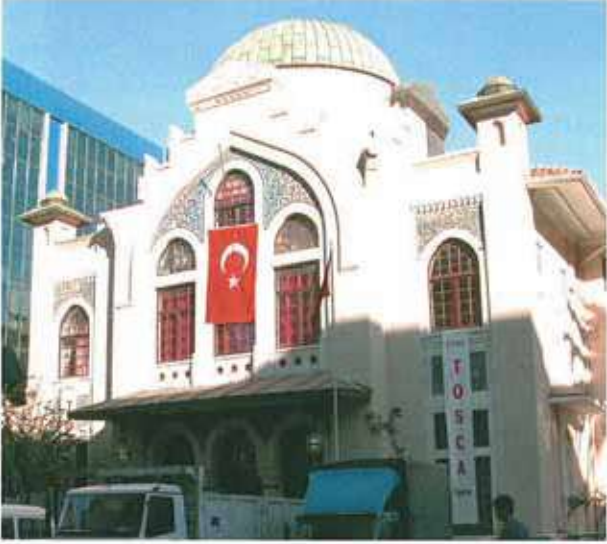
Res. 45. Elhamra Sineması (env. no: L18B689) Konak'ta, 179 ada, 2 parselde (Milli Kütüphane Caddesi no. 37).
