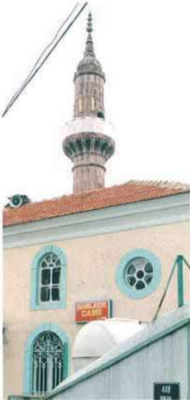
Res. 31. Damıaçık Camii, 109 ada, 5 parselde (426. Sokak no. 21) bulunmaktadır.
