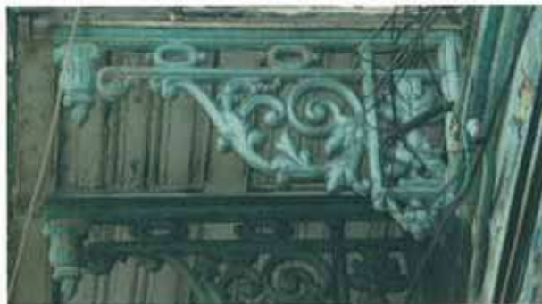
Res. 20. Cumba altı konsol elemanlarından bir örnek (382 ada, 73 parselde bulunan L18B793 numaralı yapı).
