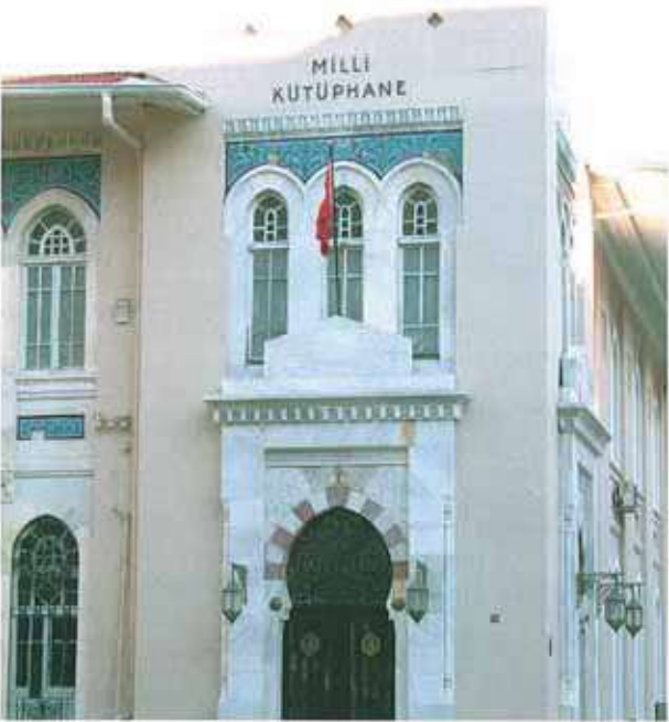
Res. 47. Milli Kütüphane (env. no. L18B690) Konak'ta, 179 ada, 1 parselde (Milli Kütüphane Caddesi no. 39).
