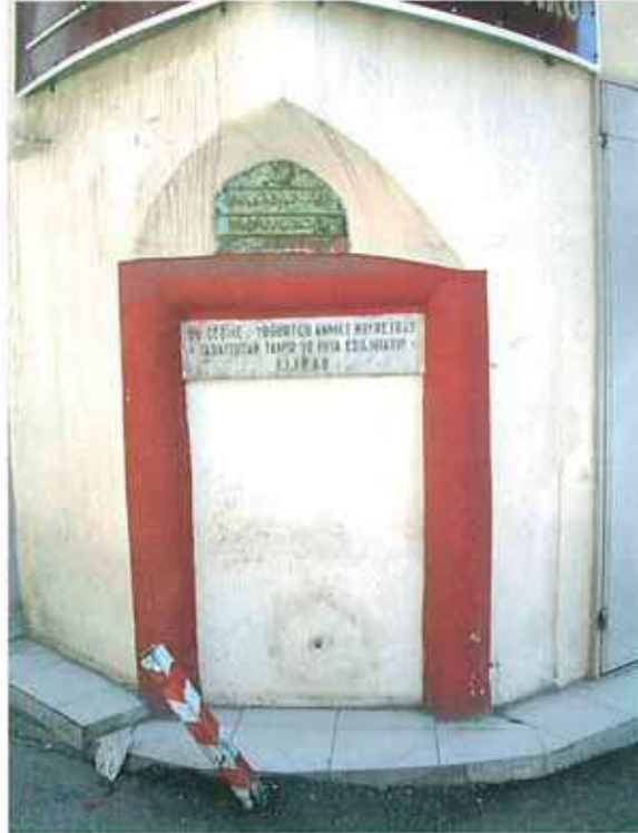
Res. 42. 834. ve 839. sokakların kesişimindeki duvar çeşmesi (env. no: L18B171).
