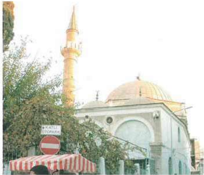
Res. 37. Kemeraltı Camii (env. no: L18B598) 237 ada, 9 parselde (866. Sokak no. 2) bulunmaktadır.
