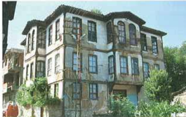
Res. 37. Abidler evi (env. no: L29B0362), Çay Sokak ile Kaya Arası Sokak köşesi.
