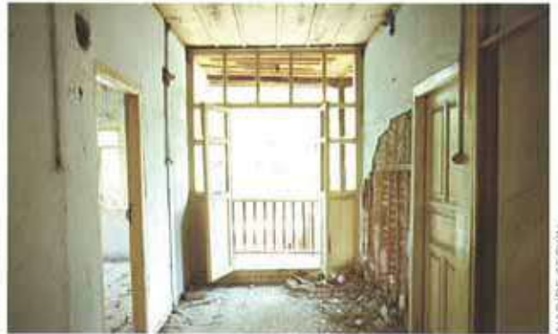
Res. 31. Necati Şen evi (env. no: L29 B0514), iç mekânından bir görünüm, Ofis Sokak.
