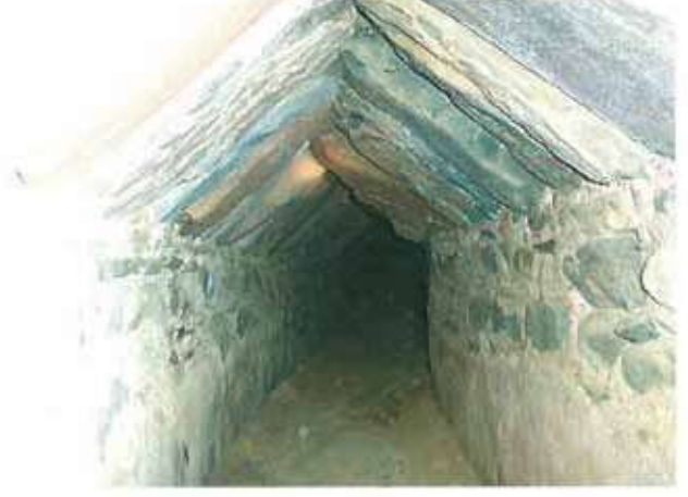
Res. 4. Tralleis su sisteminin Taşkemer-Kızlarkulesi arasındaki bölümünde yer alan üçgen tepeli galeri.
