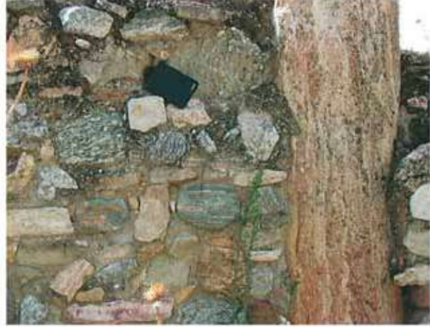
Res. 8. Tripolis stoasında traverten sütun ve duvar yapımında kullanılmış gnays, metamorfik şist, mermer, traverten türü kayalar (gözl. no: L21JJ002).
