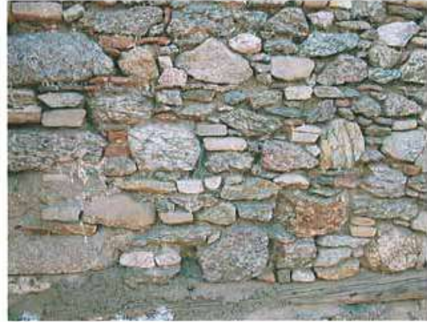
Res. 22. Buldan evlerinin duvarlarında, yörede bolca bulunan metamorfik kayalar ve daha az bulunan çökel kayalar kullanılmıştır (gözl. no: L21JJ012).
