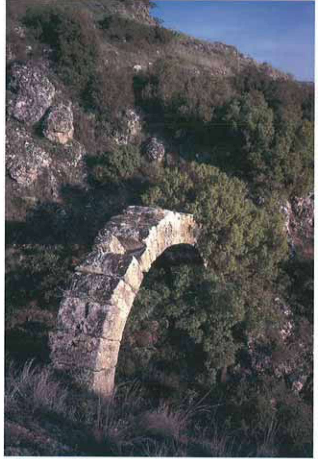
res. 5: Hierapolis, Karahayıt hattında tek gözlü su köprüsü.
