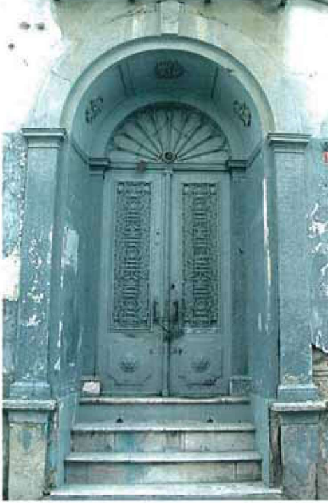
Resim 1 - Metal Çift Kanatlı, Kemerli, Üstü Havalandırmalı Kapı Tipi (Altı Masif, Üstü Parmaklıklı)
