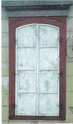
Resim 3 - Taş Söveli, Demir Kepenkli Pencere Tipi
