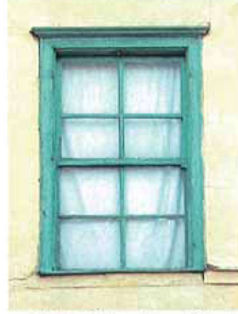
Resim 2 - Ahşap Pervazlı Giyotin Doğramalı Pencere Tipi
