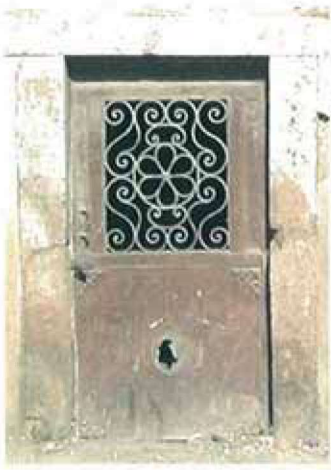
Resim 3 - Metal, Tek Kanatlı Kapı Tipi (Bodrum Kapısı)
