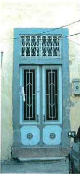
Resim 4 - Girişin Cepheyle Aynı Yüzeyde Olduğu ve Merdivenin Yola Taştığı Bir Örnek
