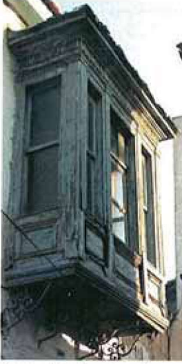
Resim 1 - Dövme Demir Konsollu Ahşap Cumba Örneği
