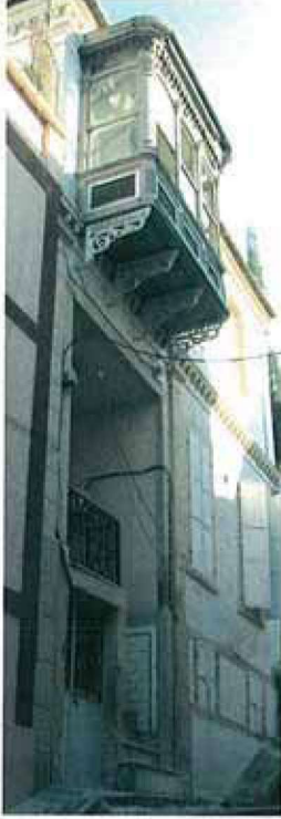
Resim 1 - Yapı Kodunun Yoldan Yükseltilerek Yarı Açık Giriş Mekanı Oluşturulması ve Girişin Üstünde Konumlanan Cumbayla Vurgulanması
