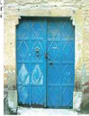
Resim 2 - Metal, Çift Kanatlı, Masif Kapı Tipi
