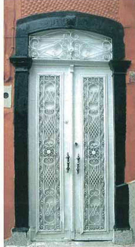
Resim 4 - Metal Çift Kanatlı, Kemerli, Üstü Havalandırmalı Kapı Tipi (Yere Kadar Parmaklıklı)
