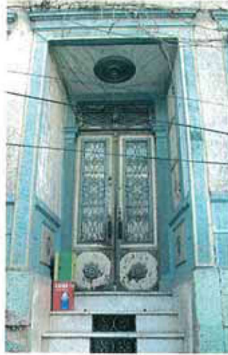
Resim 2 - Yapı Kodunun Yoldan Yükseltilerek Yarı Açık Giriş Mekanı Oluşturulması
