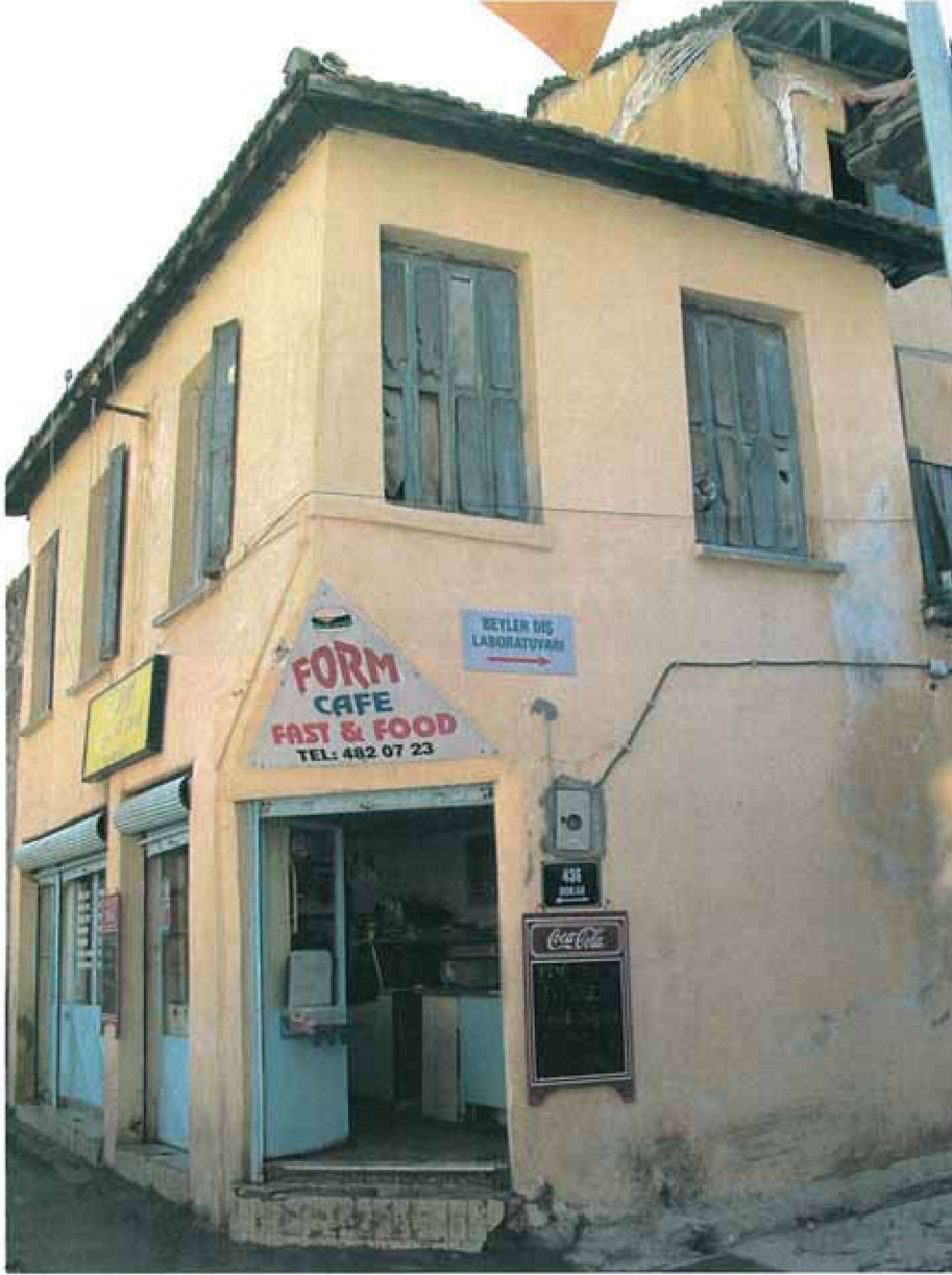
Resim 1 - Altı İş Yeri Üstü Konut Olan Bir Köşe Yapı
