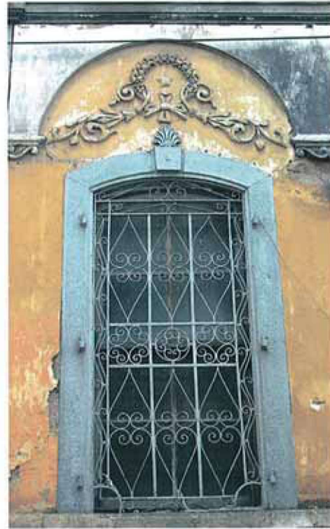
Resim 4 - Taş Söveli, Giyotin Doğramalı Demir Parmaklıklı Pencere Tipi
