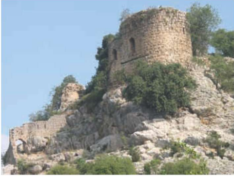
Res. 10. 523 metre rakımlı bir tepe üzerinde bulunan Kalealtı Kalesi (env. no: M36.A9.2), Kadırlı İlçesi Koçlu köyü.
