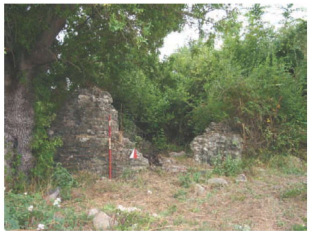
Res. 15. Kadirli ilçesi, Karatepe köyü Ayvalıpınar mevkiinde bulunan Ayvalıpınar Yapısı (env. no: N36.A9.10).
