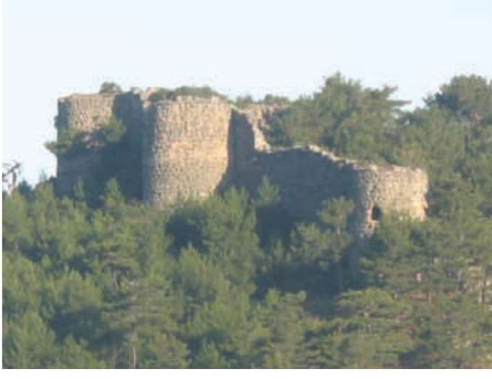
Res. 1. Merkez ilçede, Nur Dağı üzerinde bulunan Çardak Kale (env. no: N36.A9.1), güneydoğudan görünüş.
