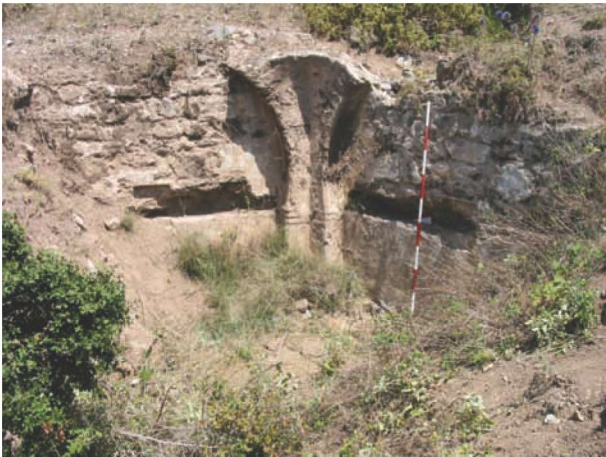
Res. 27. Merkez ilçe Çardak köyü Gökbeirler mevkiinde, tuğla tonozu ayakta kalmış bir yapı (env. no: N36.A9.24).
