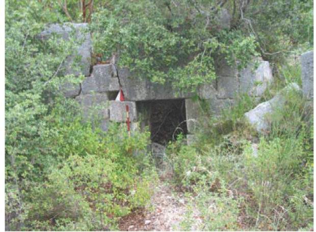
Res. 17. Merkez ilçe Sümbüllütepe Yapı 1 (env. no: N36.A9.12).
